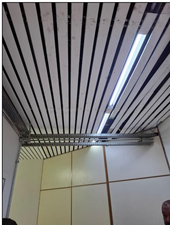
Percurso dos cabos elétricos até o quadro de energia.
