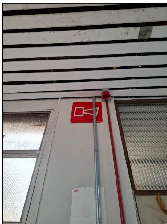
Percurso dos cabos elétricos até o quadro de energia.
