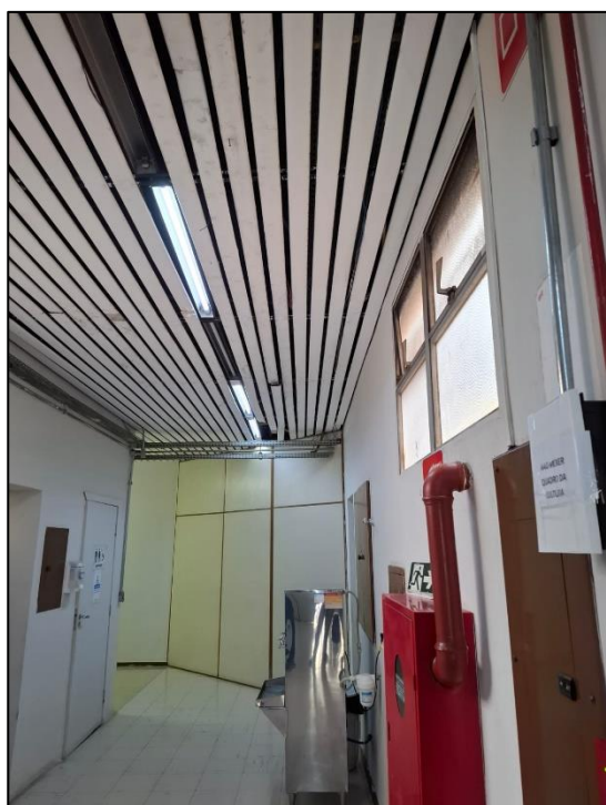
Percurso dos cabos elétricos até o quadro de energia.
