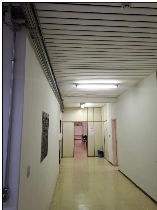
Percurso dos cabos elétricos até o quadro de energia.
