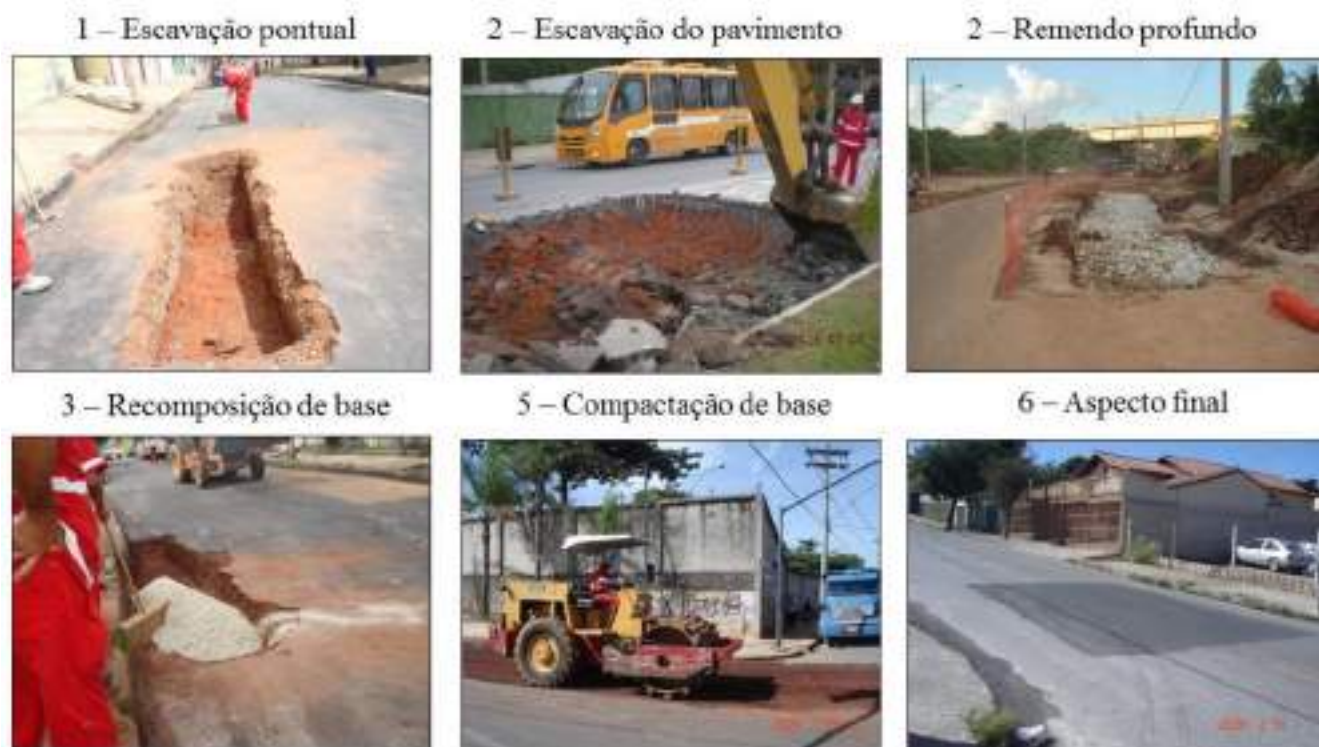
Figura 45 - Execução de Remendos Profundos
