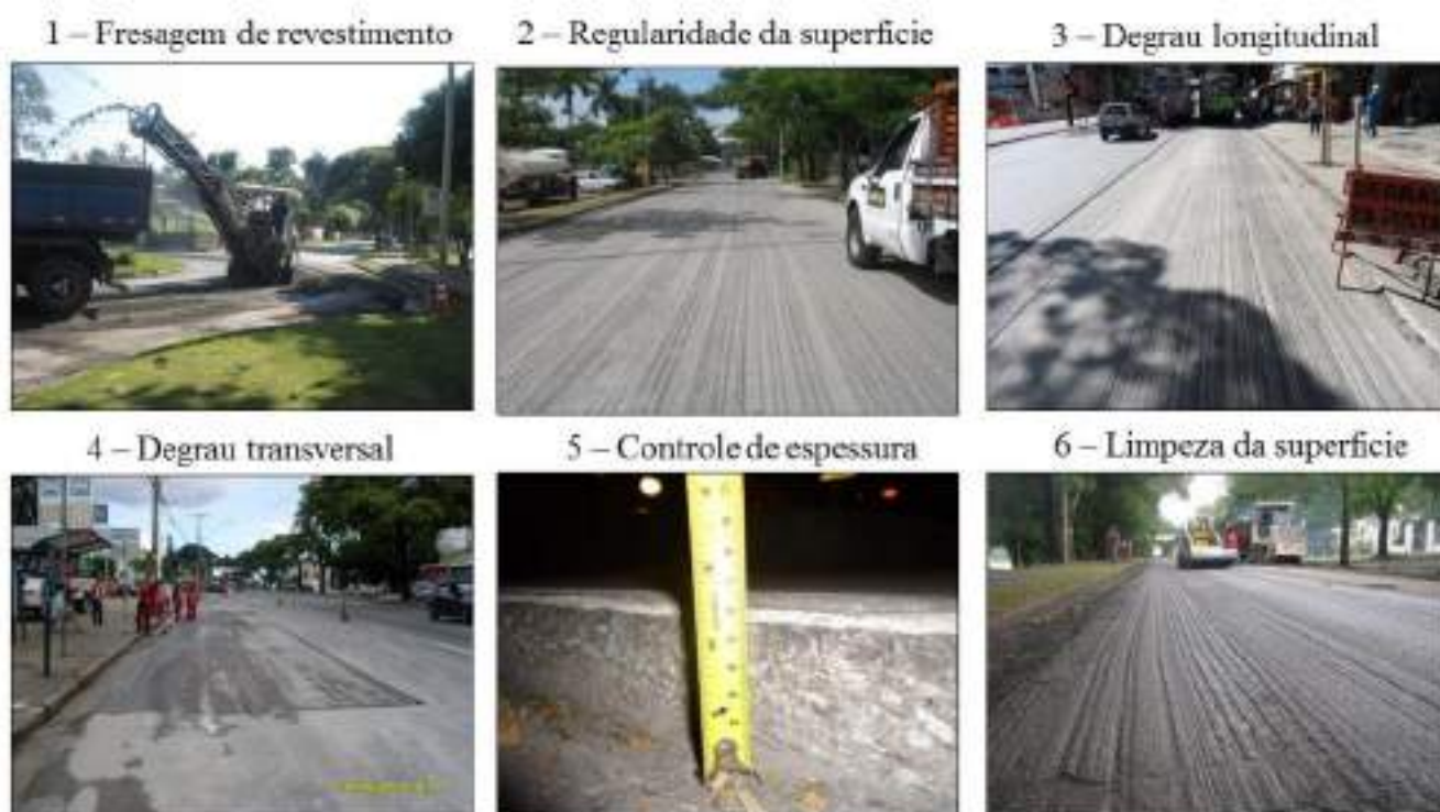
Figura 46 - Fresagem de Revestimentos Asfálticos
