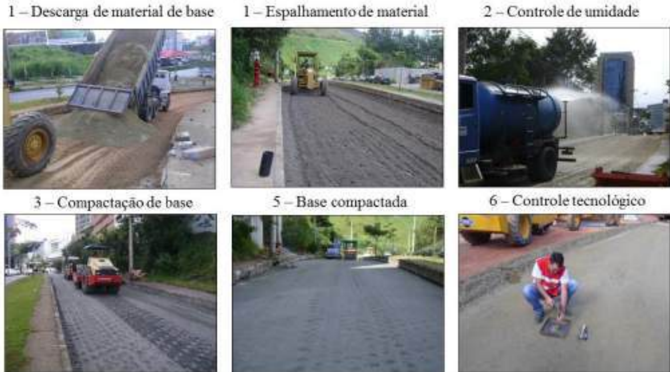
Figura 60 - Execução de Sub-base e Base de Pavimentos
