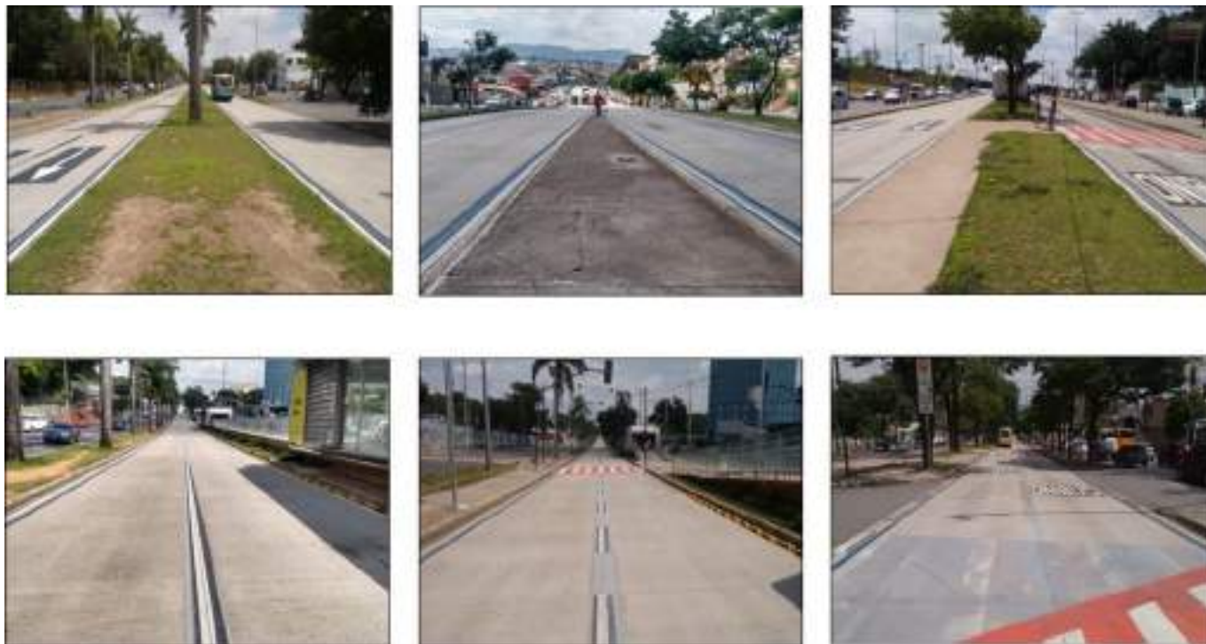
Figura 3 – Pavimento Rígido de Concreto
