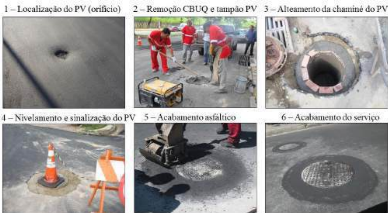
Figura 62 – Nivelamento de Poços de Visita – Sem Fresagem Preliminar
