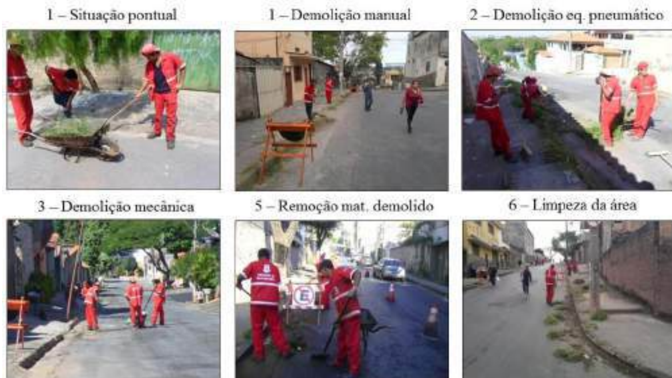
Figura 42 - Atividade Preliminar de Limpeza da Superfície do Pavimento
