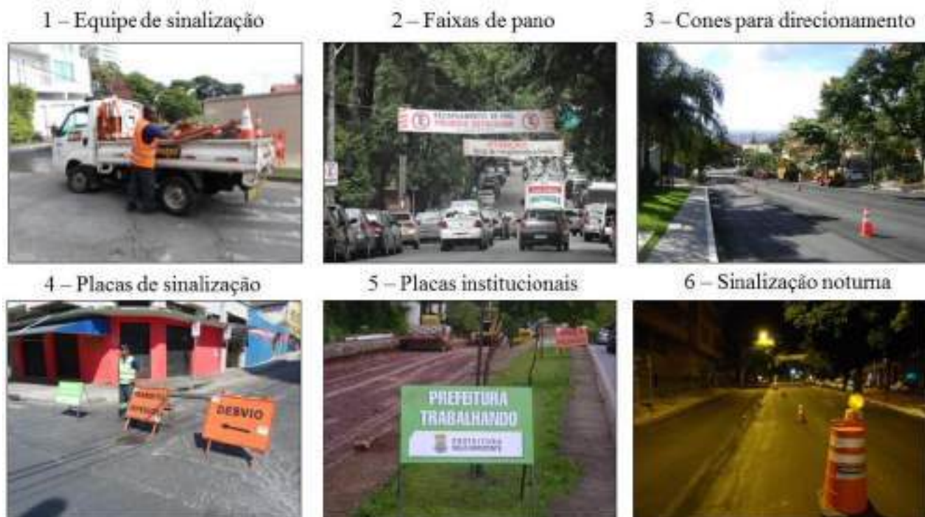
Figura 41 - Sinalização Operacional de Obra
