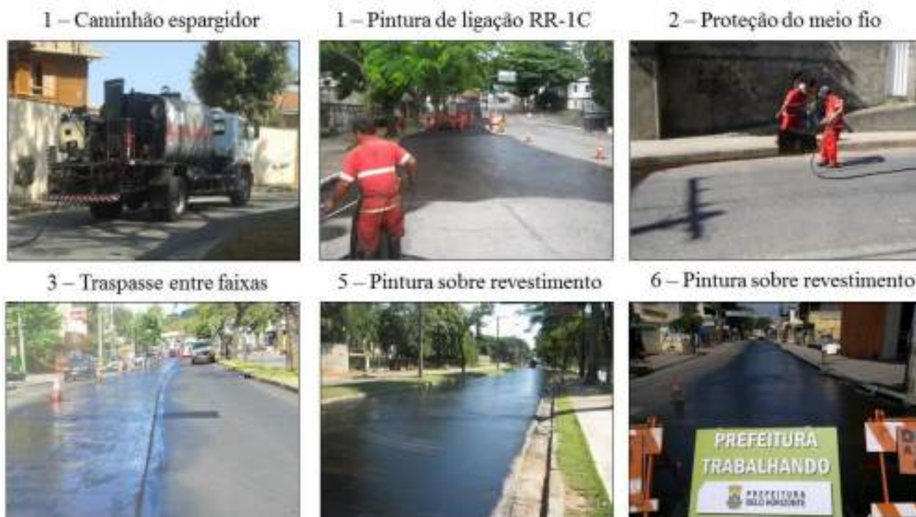
Figura 47 - Execução de Pintura de Ligação
