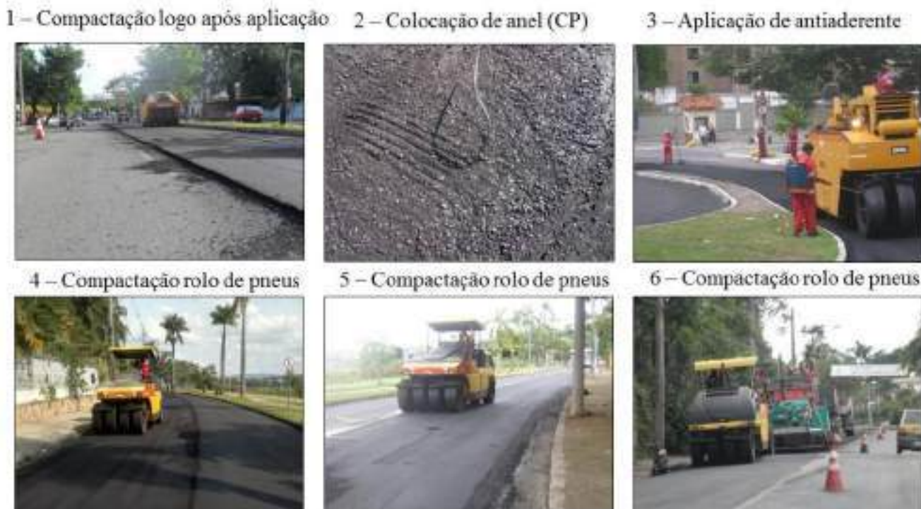
Figura 52 - Compactação de CBUQ com Rolo de Pneus
