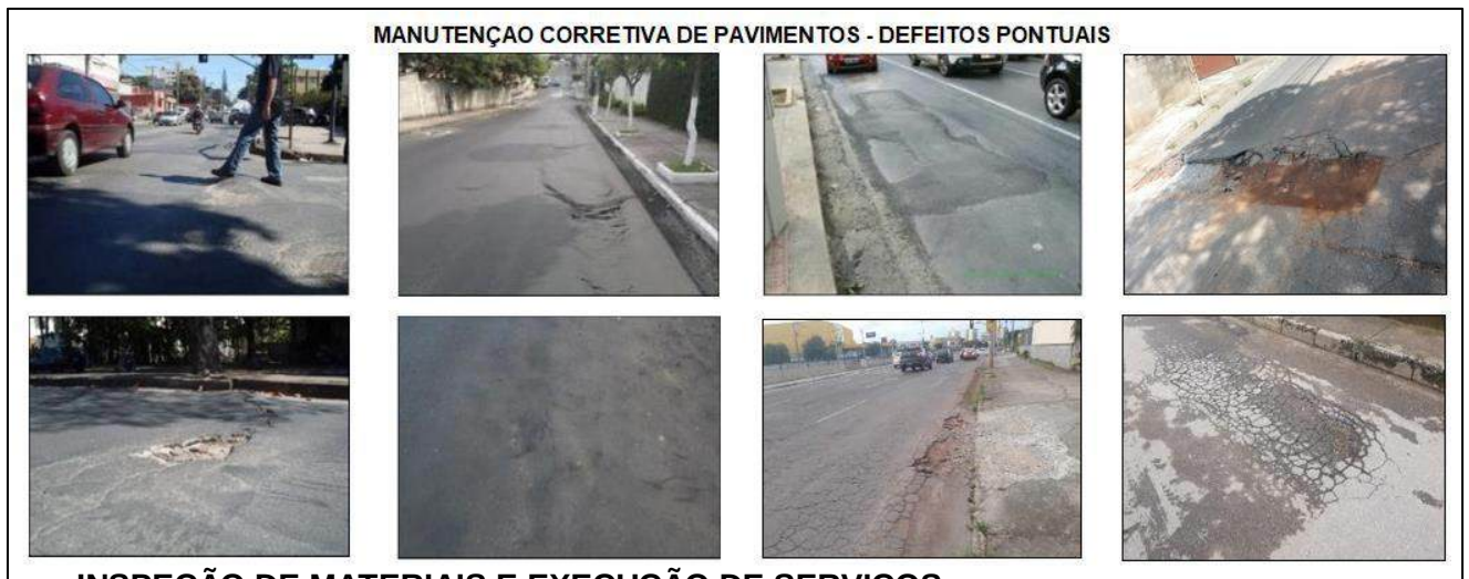
Figura 1 – Exemplos de defeitos pontuais
