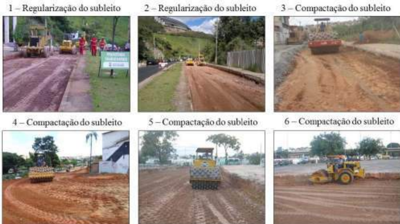
Figura 58 – Regularização e Compactação do Subleito
