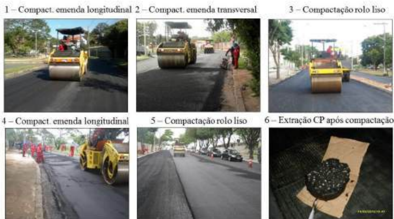
Figura 53 - Compactação de CBUQ com Rolo Liso
