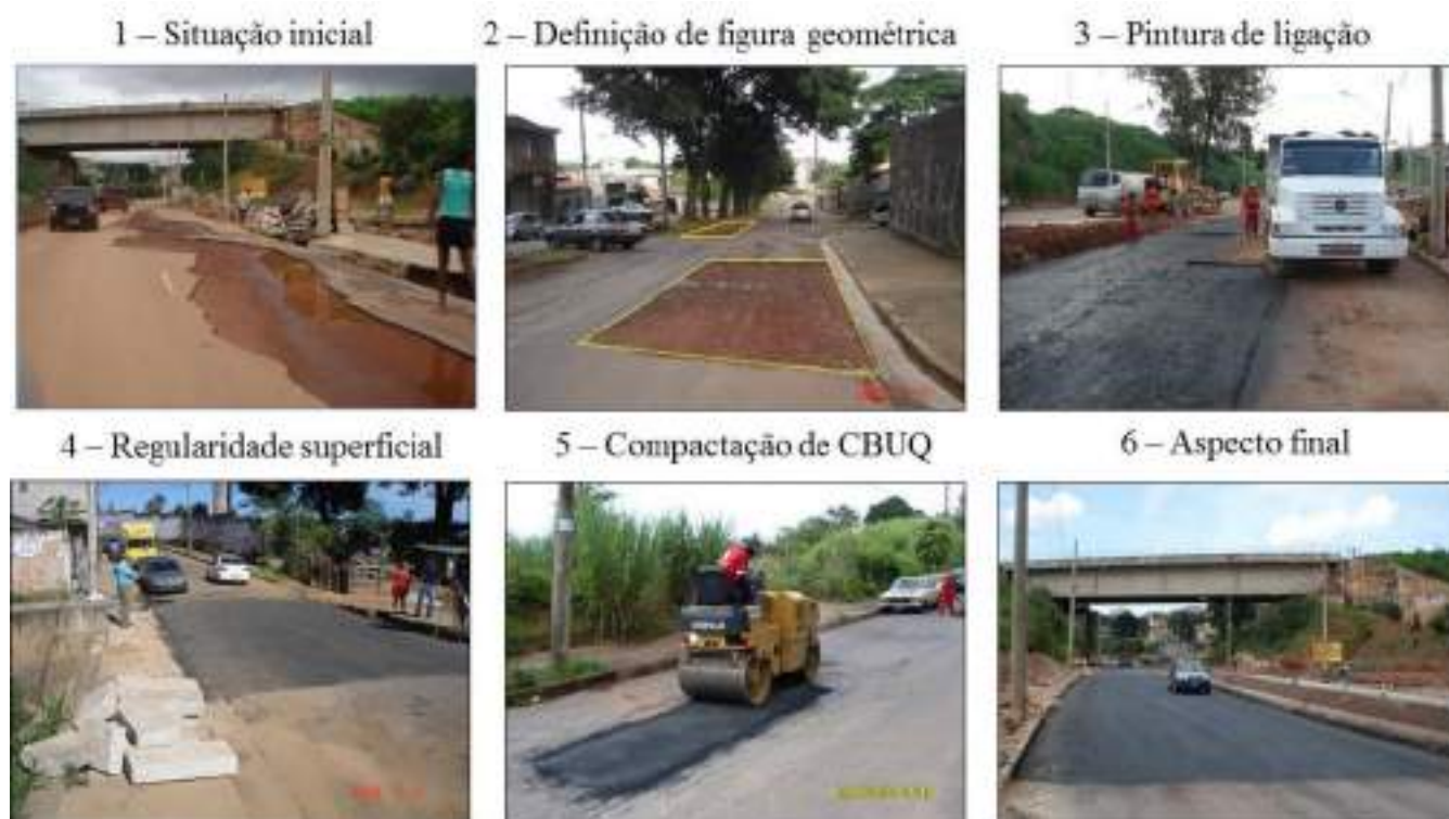
Figura 44 - Execução de Remendos Superficiais
