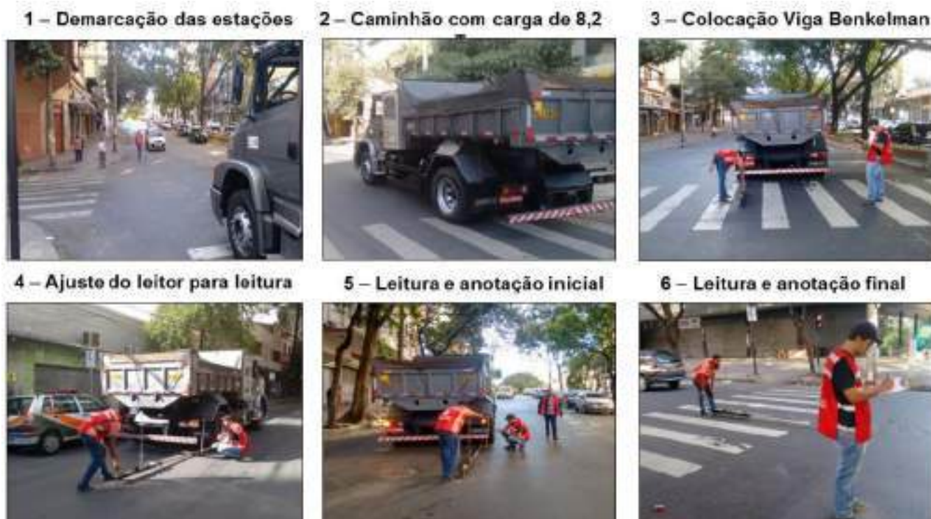
Figura 37 - Etapas da determinação das deflexões recuperáveis em pavimentos flexíveis
