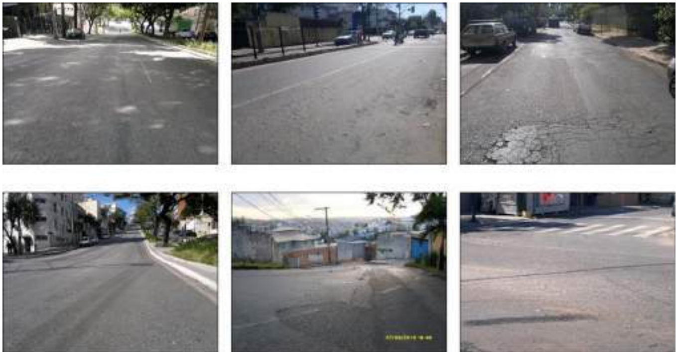
Figura 25 – Aspecto do polimento dos agregados de revestimentos asfálticos
