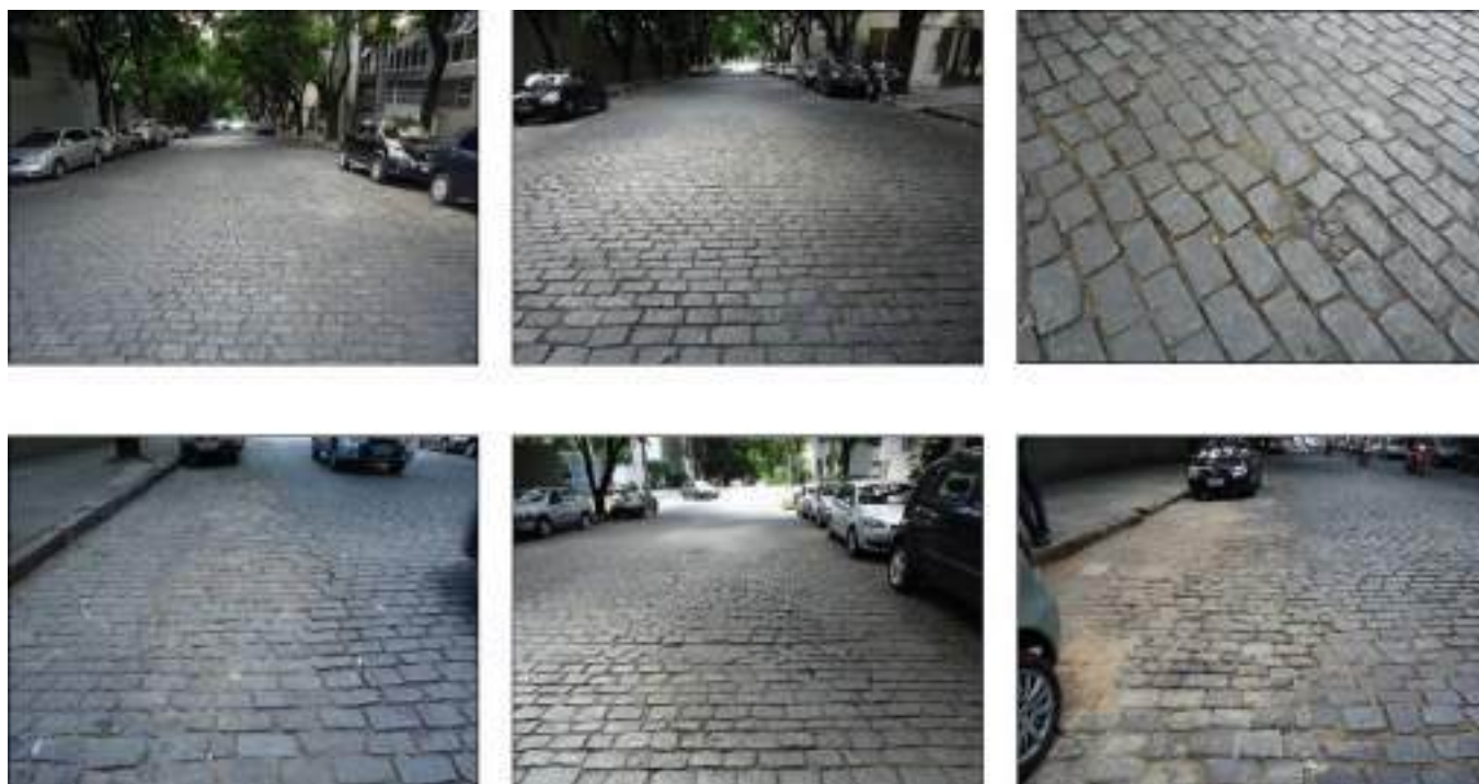
Figura 5 – Revestimento por Calçamento em Paralelepípedo
