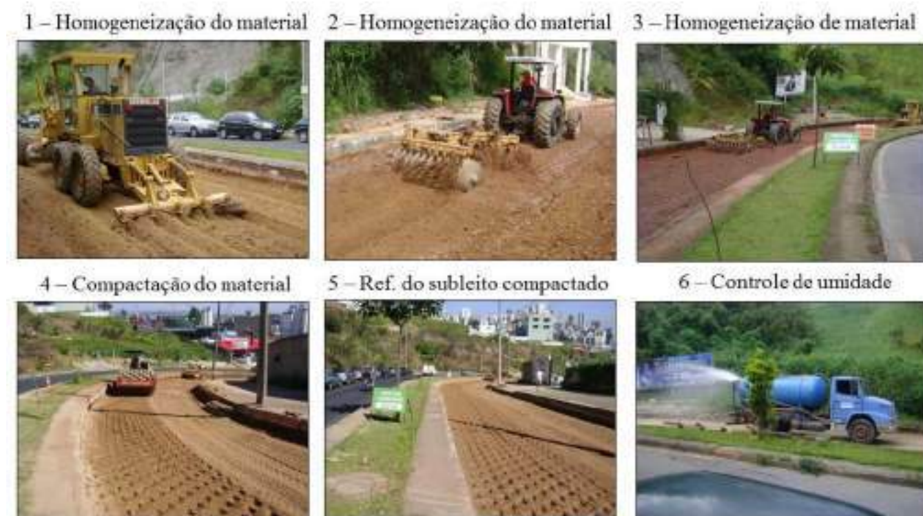
Figura 59 - Execução de Reforço do Subleito
