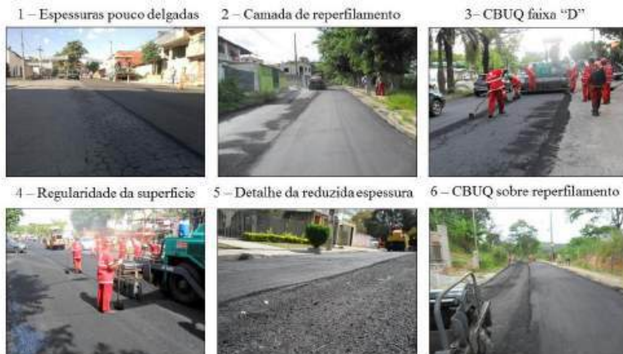
Figura 54 - Reperfilamento de Pavimentos Através de Aplicação de Camada Intermediária de CBUQ
