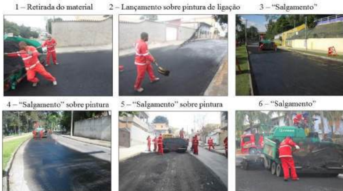
Figura 49 - “Salgamento” com CBUQ da Superfície Após Pintura de Ligação
