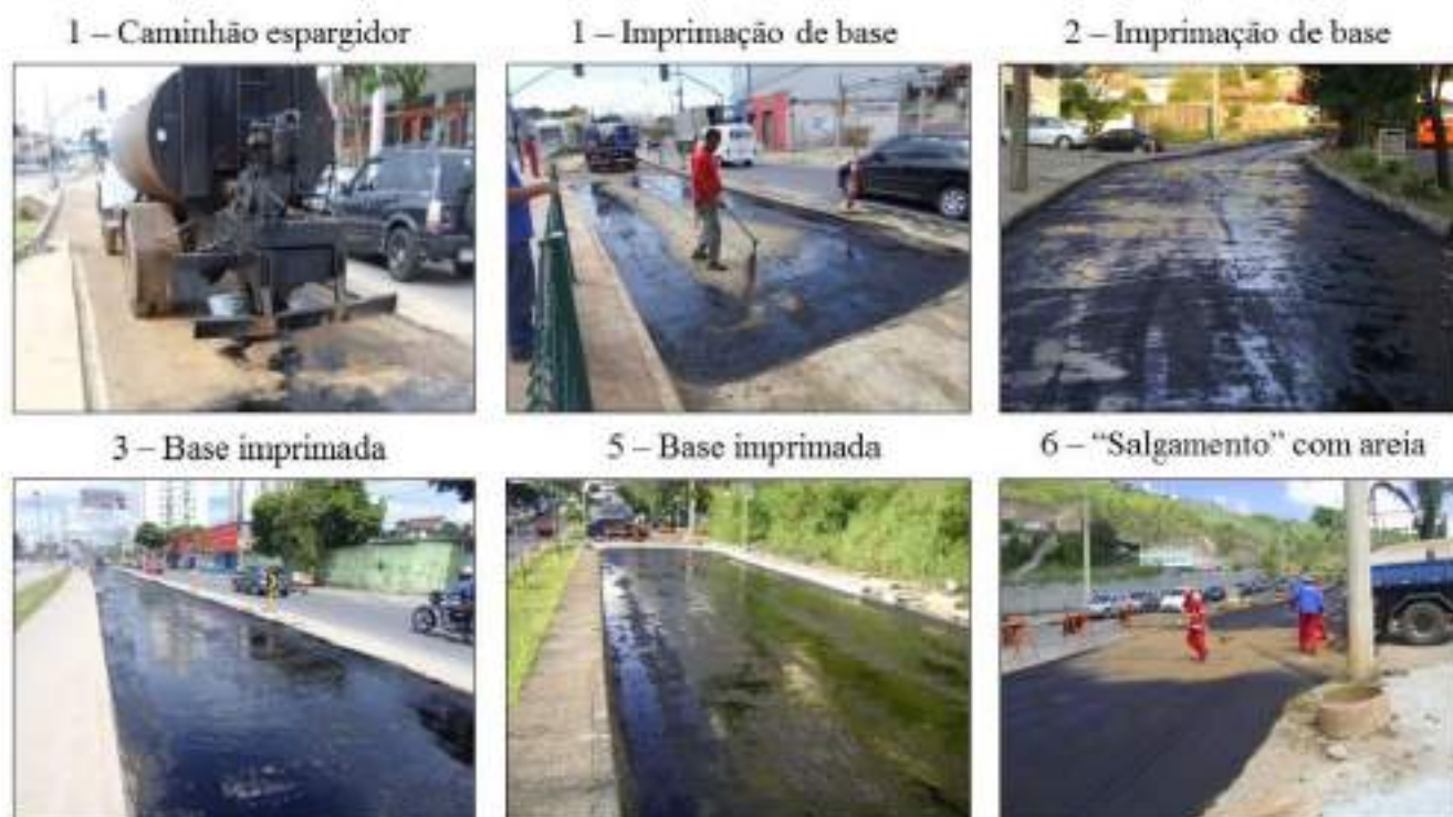
Figura 61 – Imprimação de Base de Pavimentos
