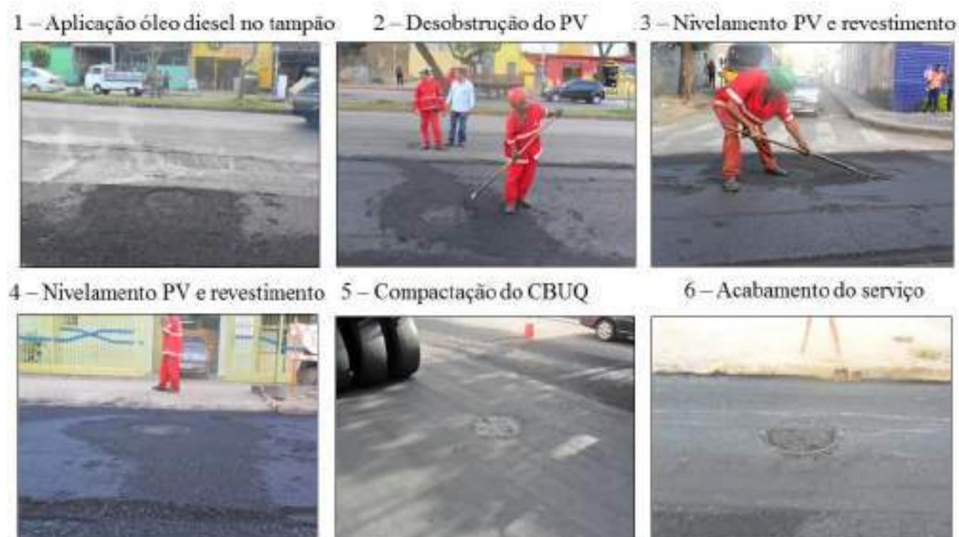
Figura 63 – Nivelamento de Poços de Visita – Sem Fresagem Preliminar
