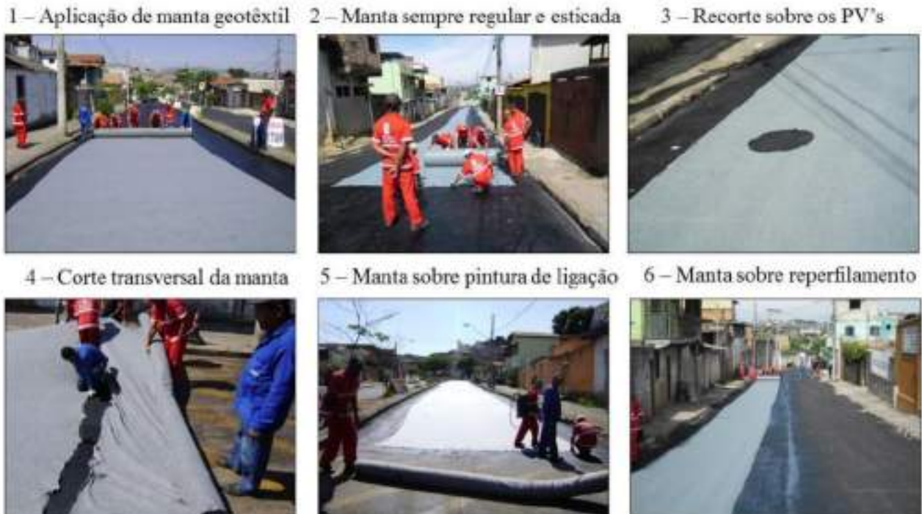
Figura 55 – Aplicação de Manta Geotêxtil como Camada Intermediária.
