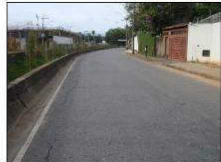
Figura 21 – Aspecto do desgaste superficial de revestimentos asfálticos
