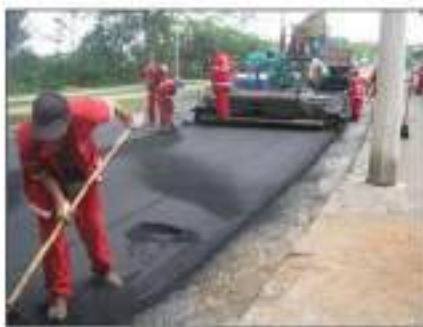
Figura 51 – Acabamento das Sarjetas
