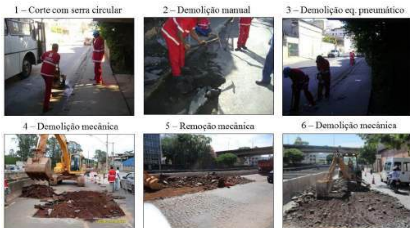
Figura 43 - Atividade Preliminar de Demolição Pontual de Revestimento Asfáltico
