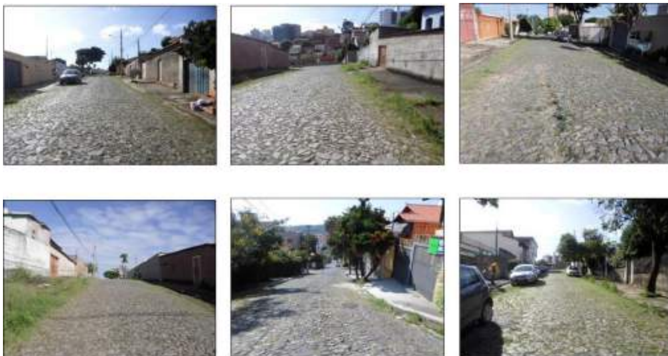
Figura 4 – Revestimento por Calçamento em alvenaria poliédrica
