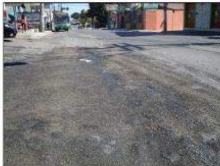
Figura 21 – Aspecto do desgaste superficial de revestimentos asfálticos
