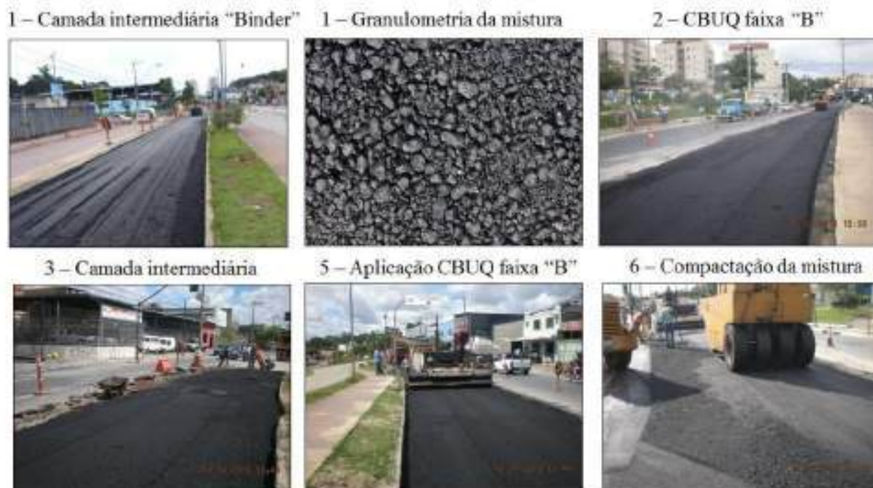
Figura 56 - Aplicação de Camada Intermediária ou Ligação
