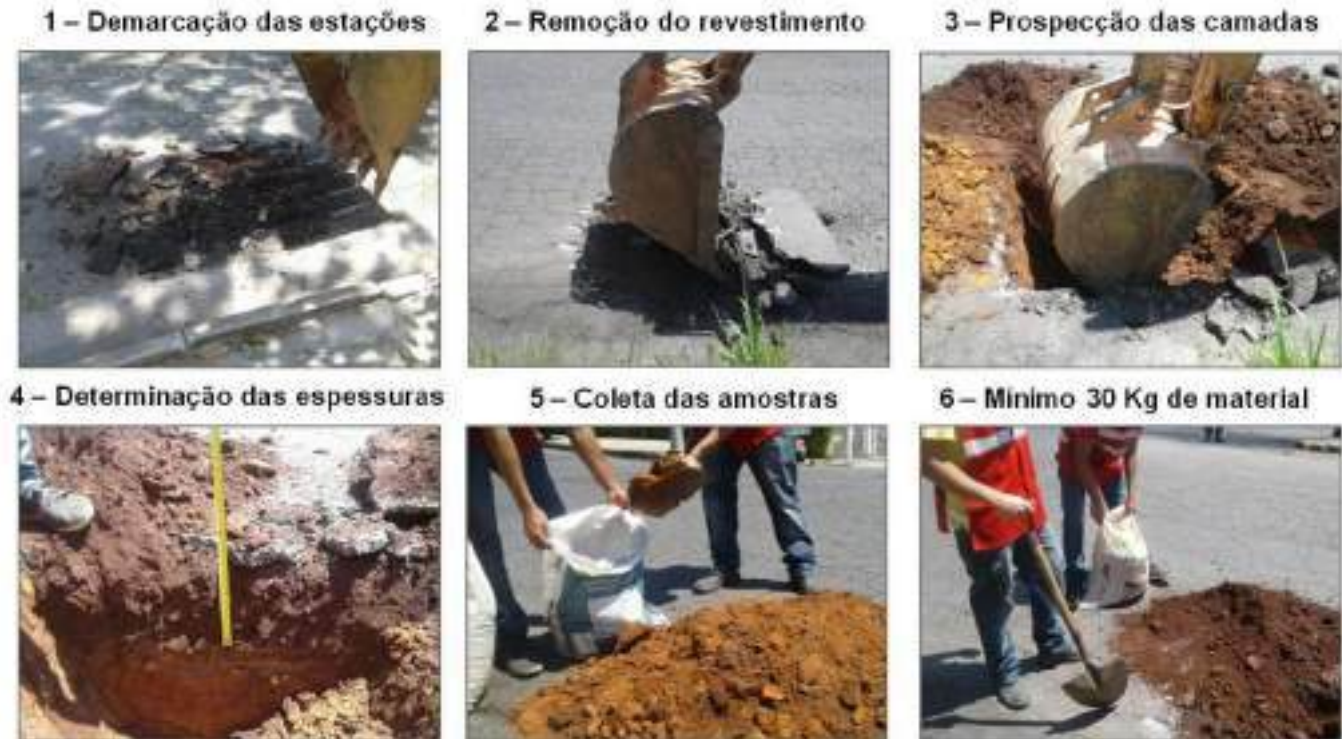
Figura 36 – Etapas da prospecção preliminar do pavimento
