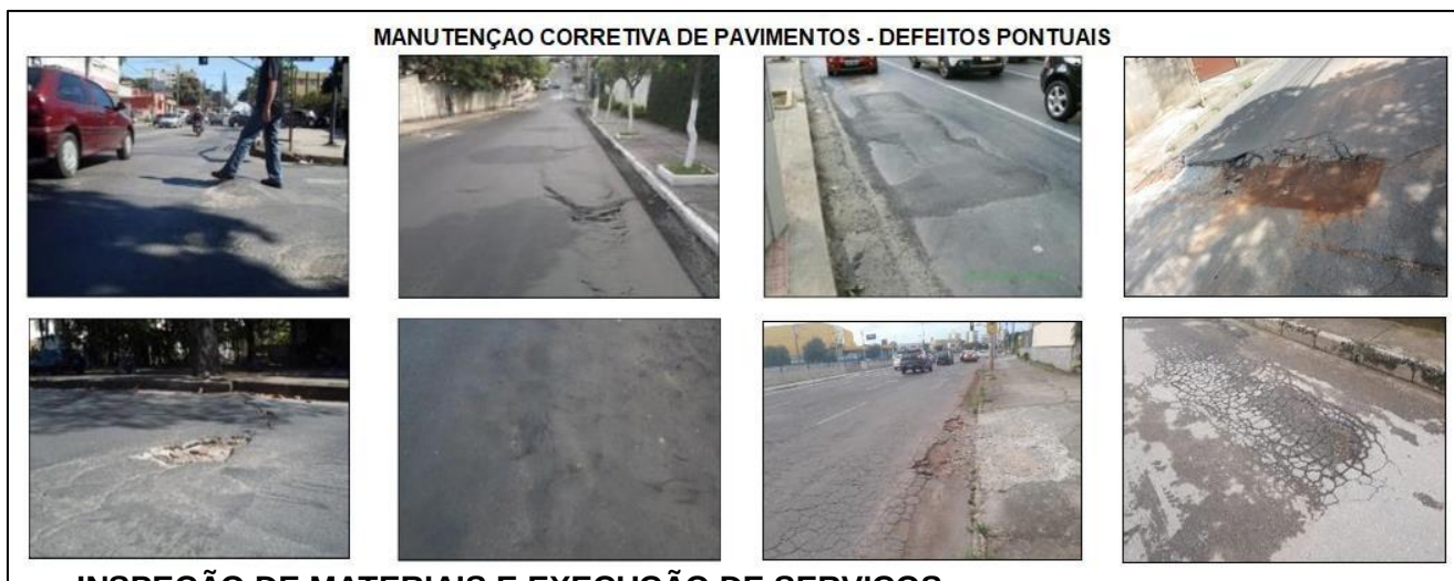
Figura 1 – Exemplos de defeitos pontuais
