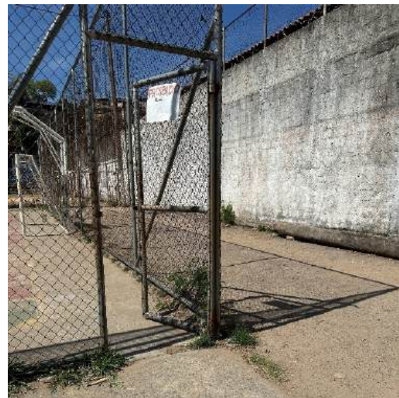
Foto 04 – Vista do portão de acesso à quadra (vistoria realizada em 29/09/2025)
