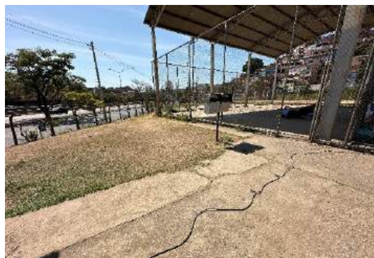
Foto 10 – Vista acesso a quadra coberta (vistoria realizada em 29/09/2025)
