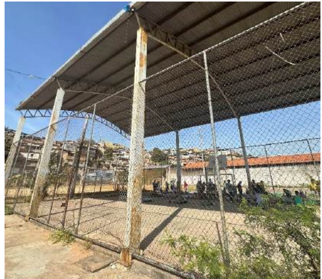
Foto 12 – Vista lateral da quadra coberta (vistoria realizada em 29/09/2025)
