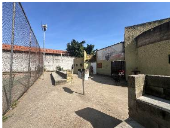
Foto 08 – Vista da sede e arquibancadas (vistoria realizada em 29/09/2025)
