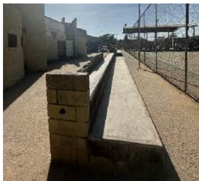
Foto 09 – Vista da arquibancada (vistoria realizada em 29/09/2025)
