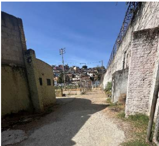
Foto 03 – Vista do acesso (vistoria realizada em 29/09/2025)
