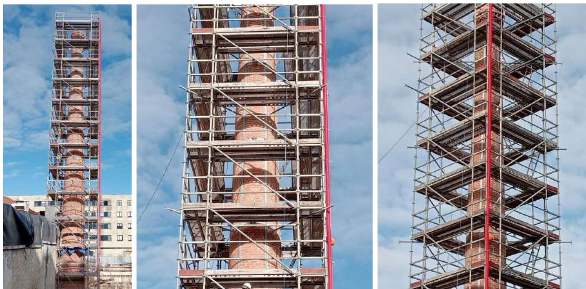
Figura 26 – Vistas gerais de andaime em Matosinhos - Portugal (Fonte: web 24 )
