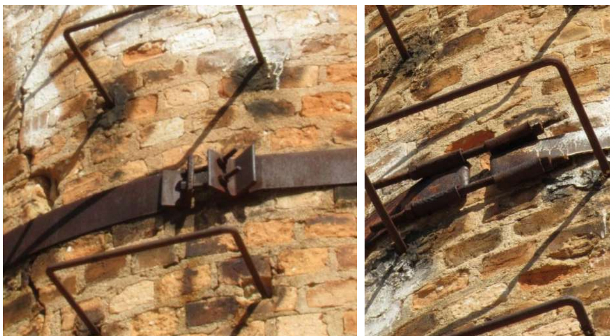
Figura 11 – ESQUERDA: Conector da cinta metálica inferior - Elevação NOROESTE --- DIREITA: Conector da cinta superior - Elevação NOROESTE
