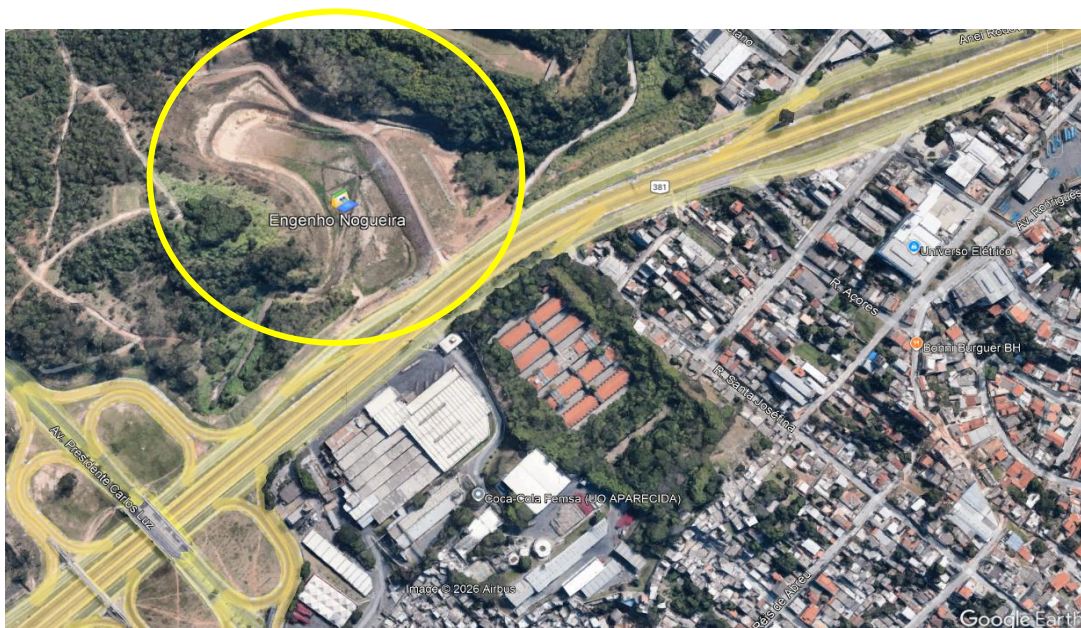
Figura 3: Barragem Engenho Nogueira
