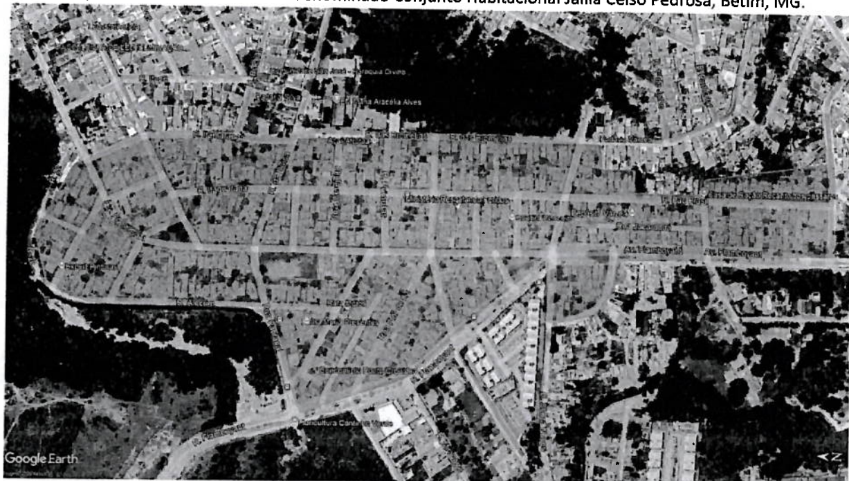
Imagem 4 – Vista aérea do NUI denominado Conjunto Habitacional Jilila Celso Pedrosa, Betim, MG.
