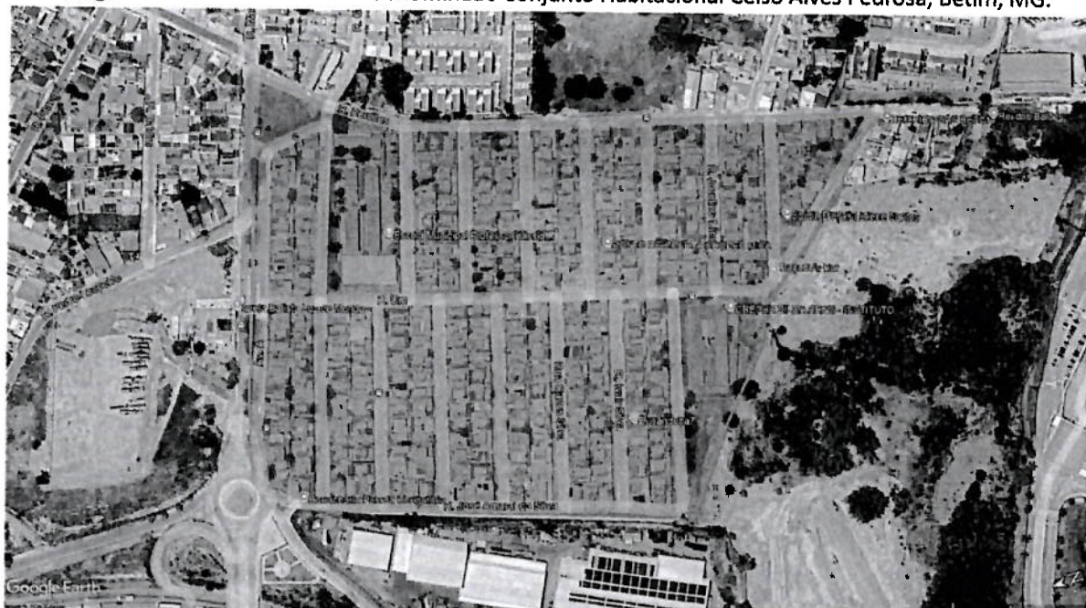
Imagem 2 – Vista aérea do NUI denominado Conjunto Habitacional Celso Alves Pedrosa, Betim, MG.
