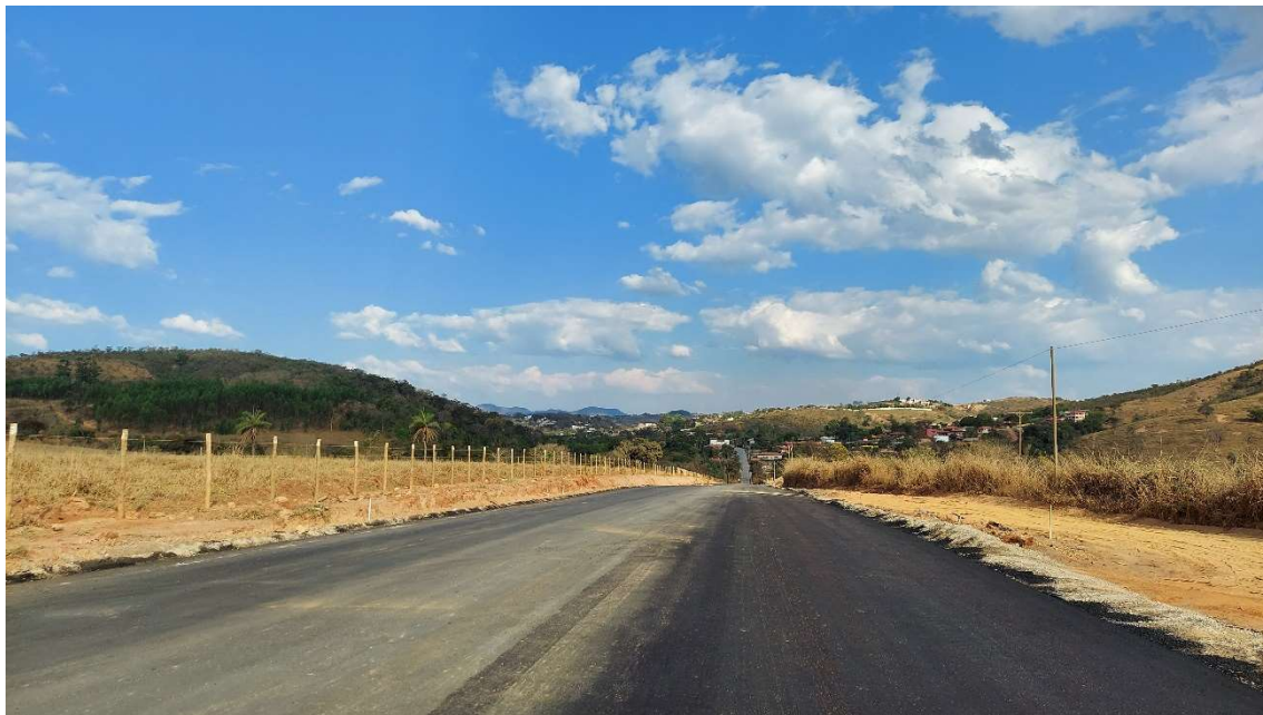
Figura 3: Via sentido Jaboticatubas. A pista será implantada no lado esquerdo da via.
