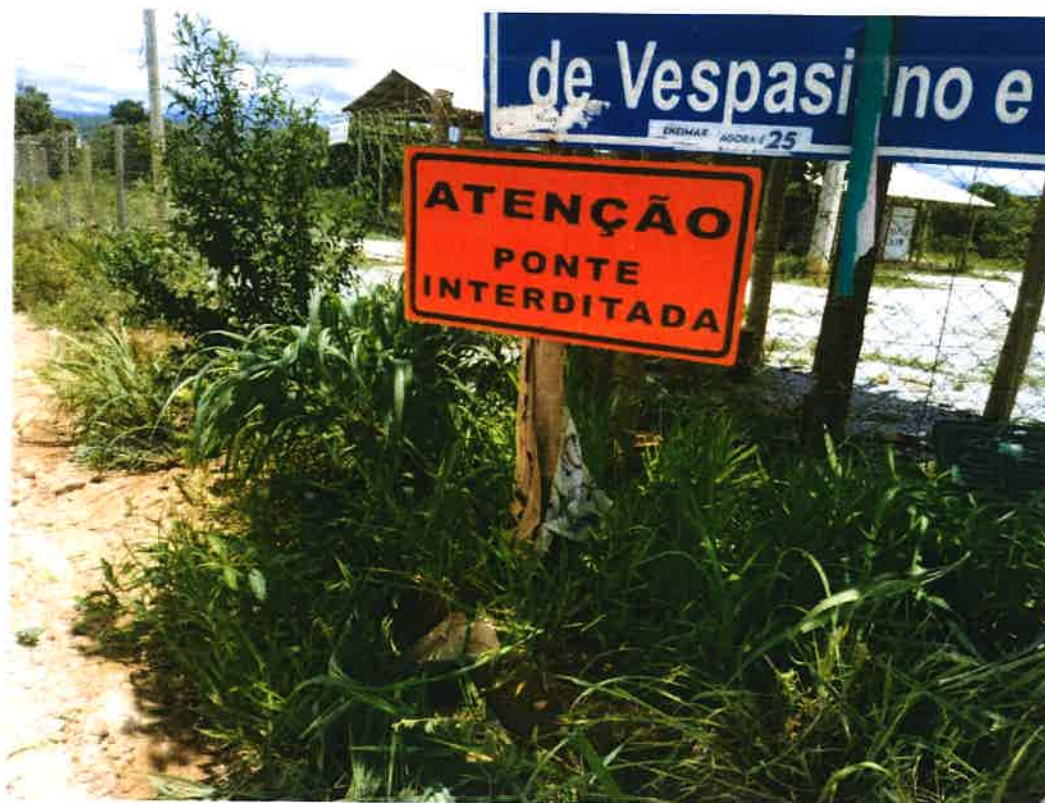
Figura 3: Fixação de sinalização
