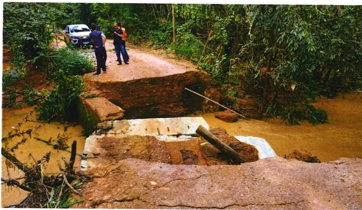
Figura 3: Colapso total da ponte
