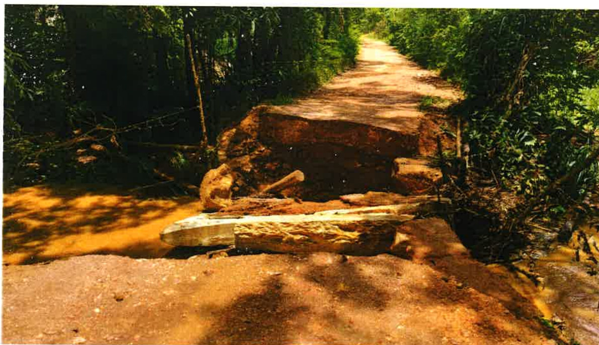
Figura 3: Colapso total da ponte
