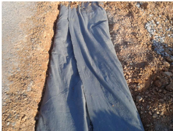
Figura 6: Fechamento manta geotêxtil
