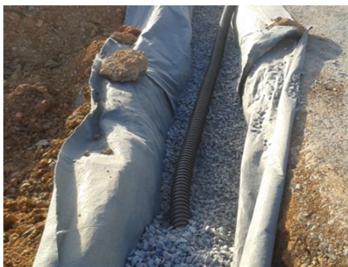
Figura 5: Aplicação de brita e tubo
