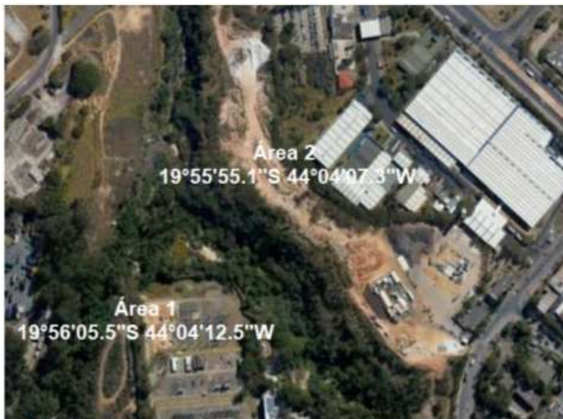
Imagem 1 – Vista geral das áreas de armazenamento.
