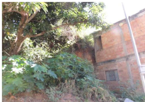
FIGURAS 22 e 23: Vista de parte do setor de risco identificado. Baixo padrão construtivo, taludes verticalizados não estabilizados, sinais de instabilidade. Área parcialmente urbanizada – Rua Anchieta.
