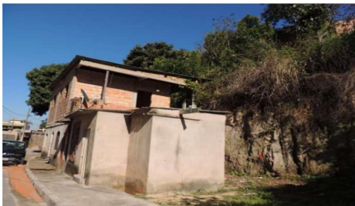
FIGURAS 22 e 23: Vista de parte do setor de risco identificado. Baixo padrão construtivo, taludes verticalizados não estabilizados, sinais de instabilidade. Área parcialmente urbanizada – Rua Anchieta.
