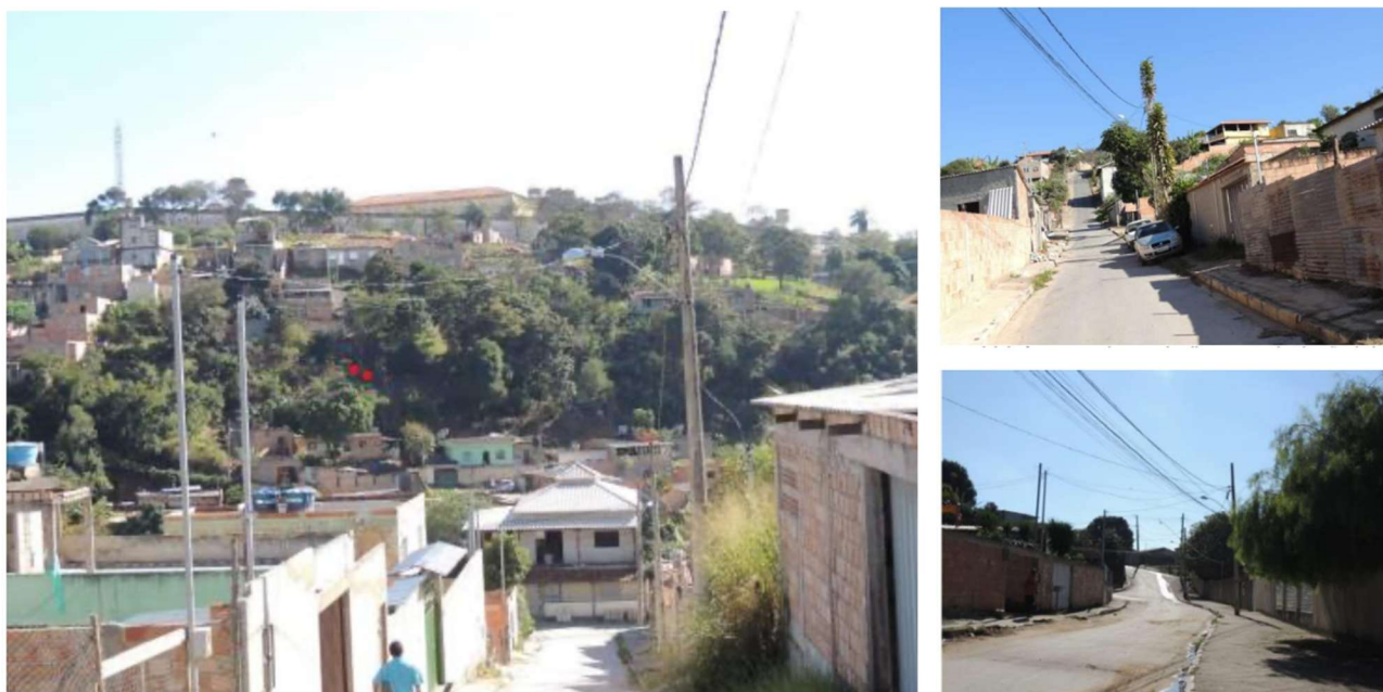
FIGURAS 24 a 26: Urbanização executada após PMRR de 2007 – Vila Estaleiro.
