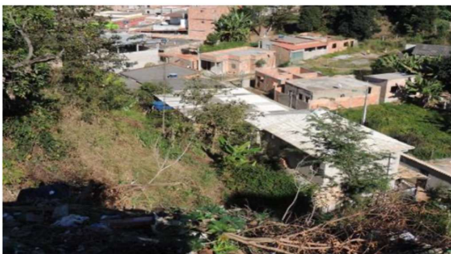
FIGURA 20: Vista de parte do setor de risco identificado. Médio padrão construtivo, taludes verticalizados não estabilizados em sua totalidade, com indícios de instabilidade.
