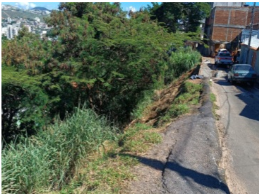
Vista Lateral da encosta SR 1.1. Fonte: Arquivo Interno, SEINFRA/2025.
