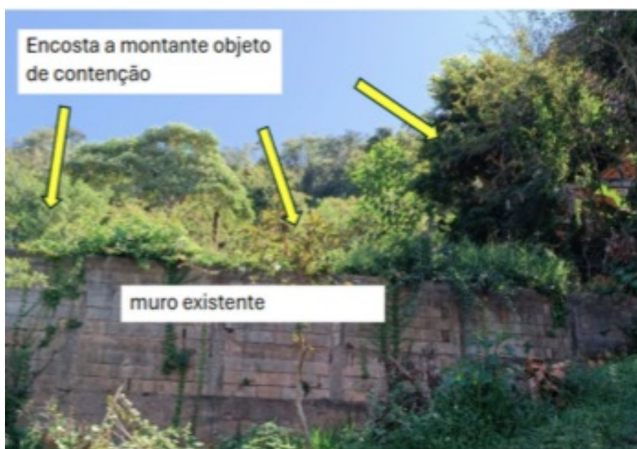
Vista Frontal da encosta SR 9.4. Fonte: Arquivo Interno, SEINFRA/2025.
