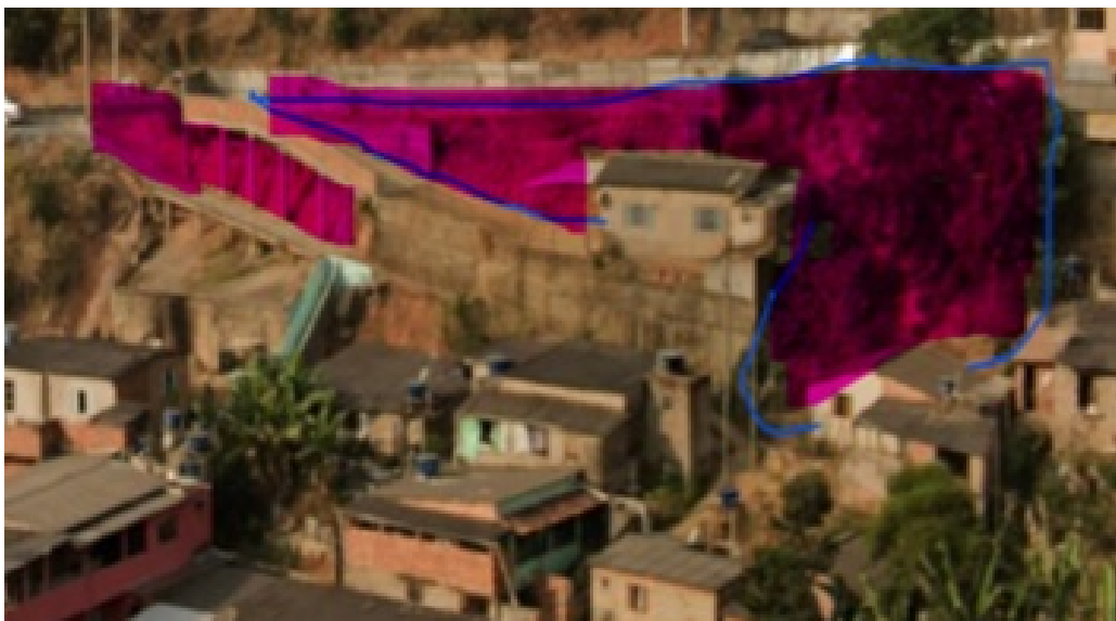
Vista Frontal da encosta SR 6.1. Fonte: Arquivo Interno, SEINFRA/2025.
