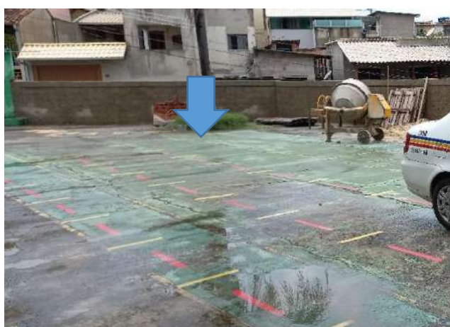
FOTO 04 - VISTA DA QUADRA ONDE SERÁ COBERTA EM ESTRUTURA METÁLICA.
