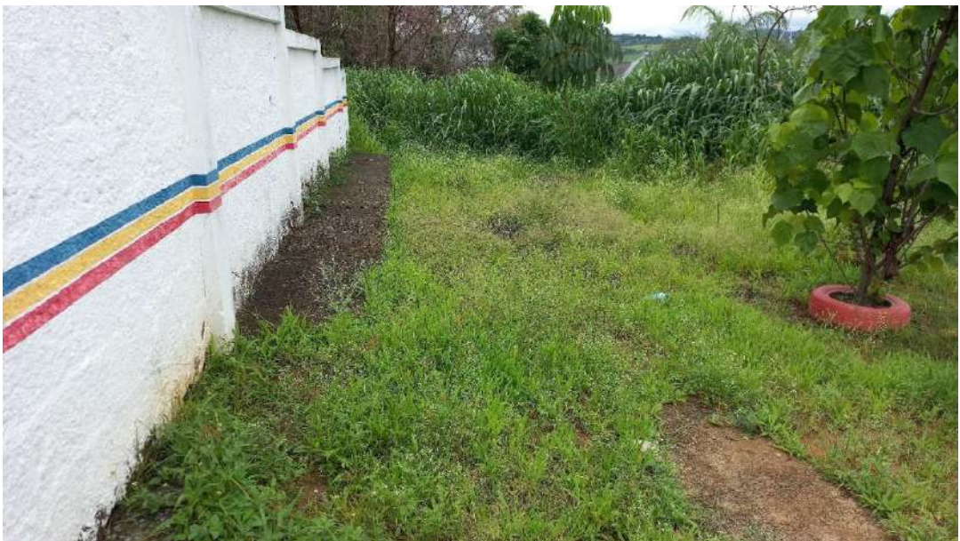
FOTO 08 - VISTA DA LATERAL DO MURO AO LADO DA ENTRADA PRINCIPAL DA ESCOLA.
