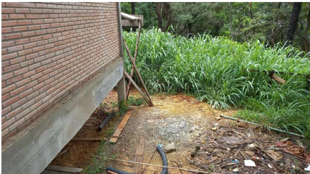
FOTO 10 - VISTA DOS FUNDOS DA AMPLIAÇÃO QUE ESTÁ SEND O CONCLUÍDA ONDE PASSARÁ O MURO.
