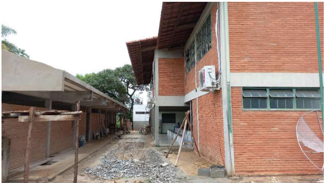
FOTO 07 – VISTA DA AMPLIAÇÃO QUE ESTÁ SENDO CONCLUÍDA.
