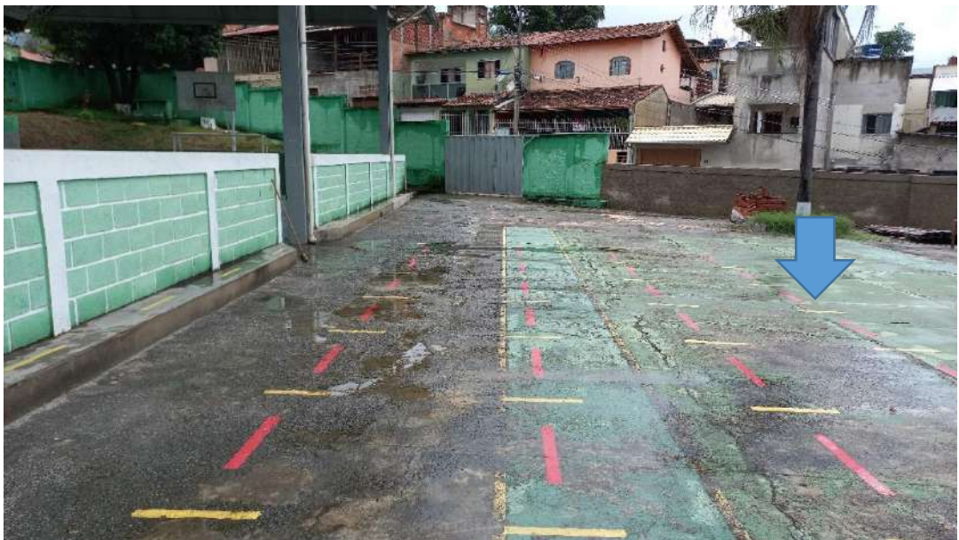
FOTO 05 – VISTA DA QUADRA ONDE A COBERTURA DE ESTRUTURA METÁLICA SERÁ CONSTRUÍDA.
