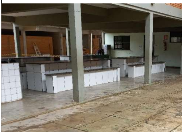
FOTO 03 - VISTA DA CANTINA PRÓXIMO AO LOCAL PARA IMPLANTAÇÃO DA PLATAFORMA PARA ACESSO AO SEGUNDO PAVIMENTO.
