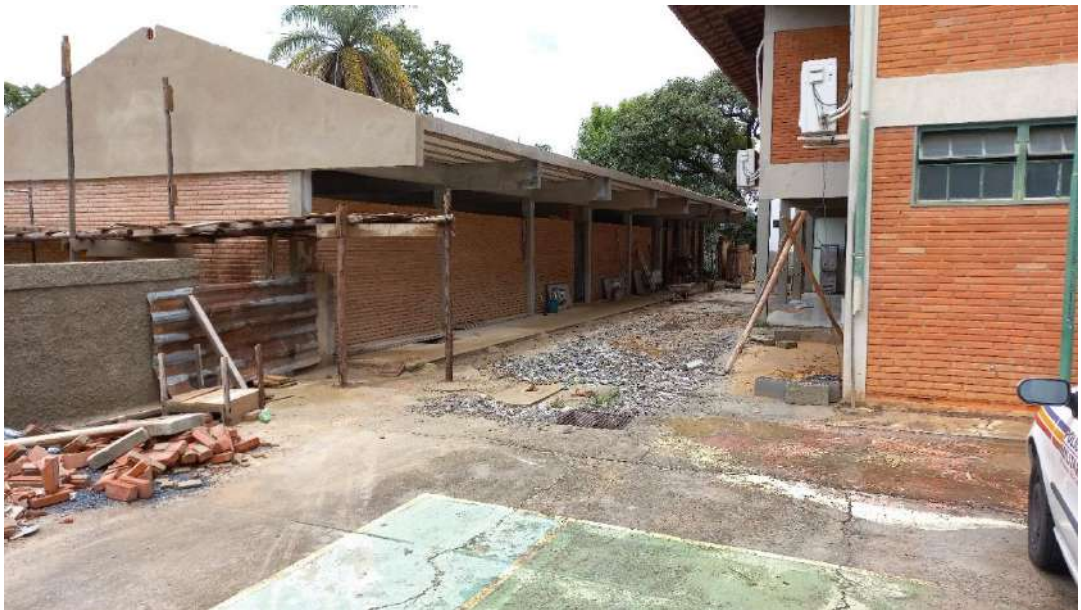
FOTO 06 - VISTA DA AMPLIAÇÃO QUE ESTÁ SENDO CONCLUÍDA.
