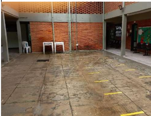
FOTO 01 - VISTA DO LOCAL PARA IMPLANTAÇÃO DA PLATORMA PARA ACESSO AO SEGUNDO PAVIMENTO.
