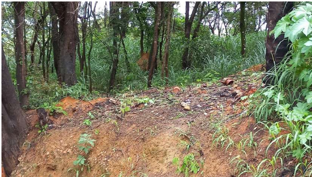
FOTO 15 – VISTA DOS FUNDOS DO TERRENO DA RUA JOÃO ARCANJO ALVES.
