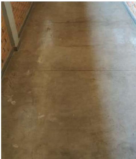
FOTO 19 – PISO EM GRANITINA. SUBSTITUIÇÃO NA CIRCULAÇÃO DO 2º PAVIMENTO DAS SALAS.
