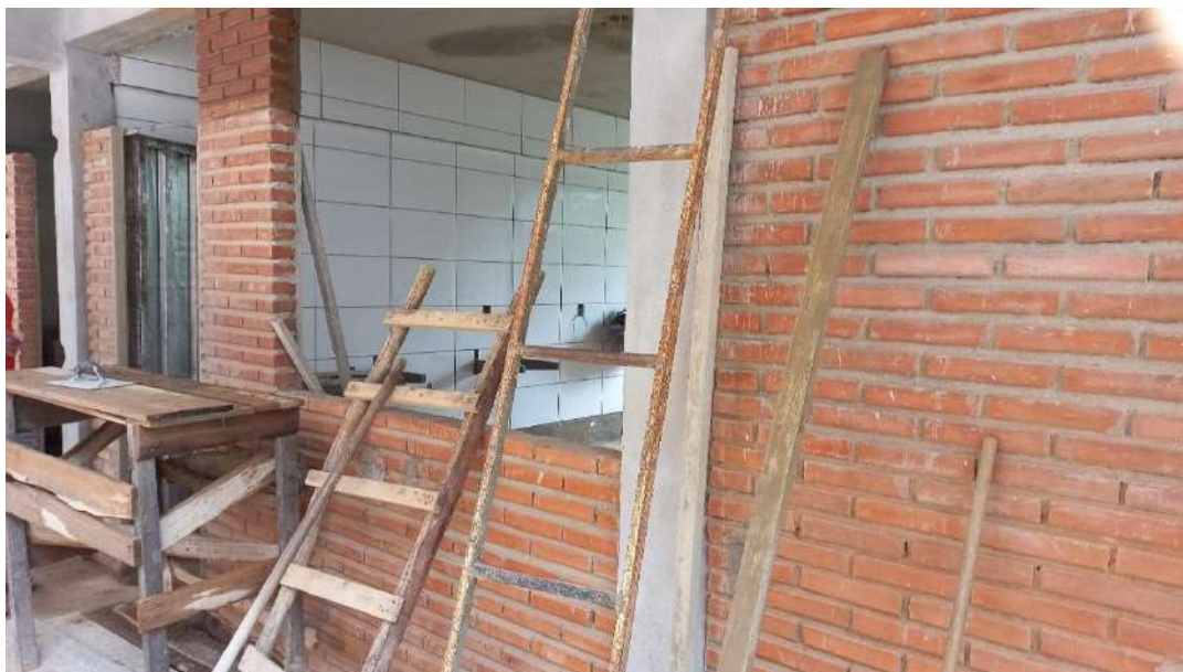
FOTO 11 – VISTA DA AMPLIAÇÃO QUE ESTÁ SENDO CONCLUÍDA.
