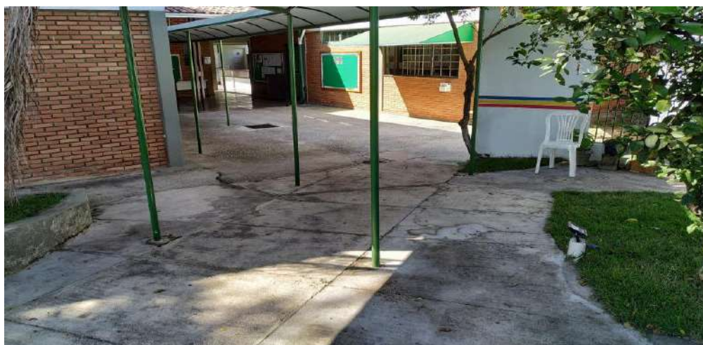
FOTO 25 – VISTA DA ENTRADA PRINCIPAL NA AVENIDA DAS NASCENTES 650.
