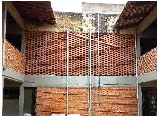
FOTO 02 – VISTA DO LOCAL PARA IMPLANTAÇÃO DA PLATORMA PARA ACESSO AO SEGUNDO PAVIMENTO.
