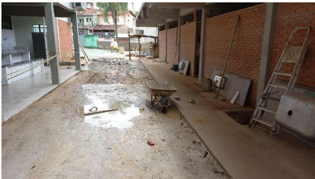
FOTO 12 - VISTA DA AMPLIAÇÃO QUE ESTÁ SENDO CONCLUÍDA.
