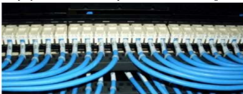
Figura 05 - Fixação do cabeamento permanente no painel de conexão.
