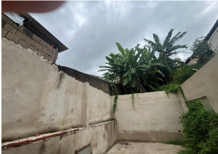
Figura 14: Cômodo em construção
