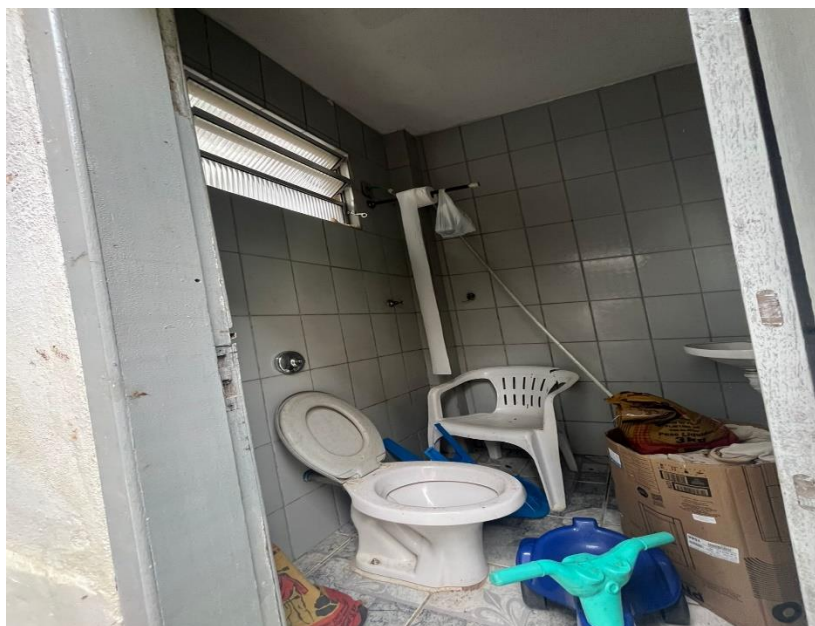
Figura 10: Banheiro da Área Externa
