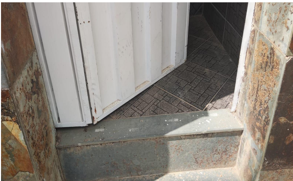
Figura 1: Hall de Entrada 1 (Portão Empenado)
