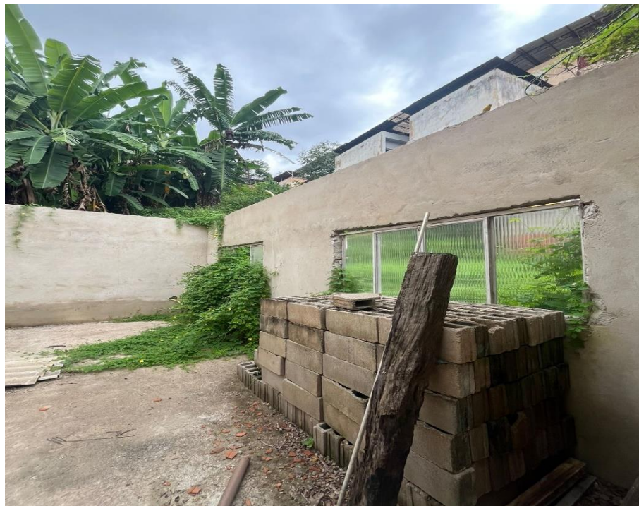
Figura 15: Cômodo em construção
