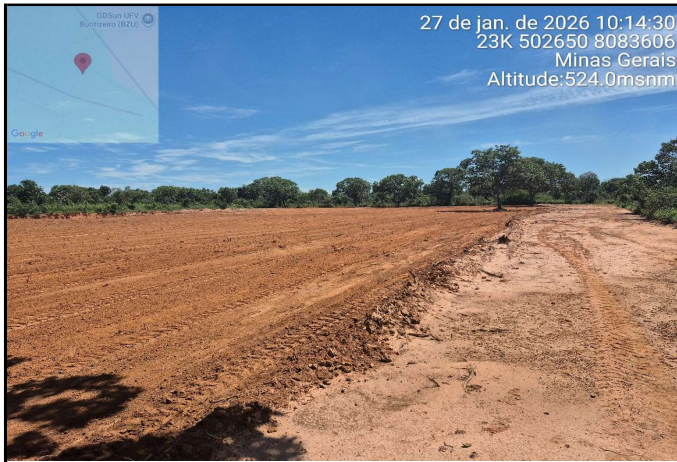
FT.03 - FOTO DA ÁREA DE INTERVENÇÃO.
