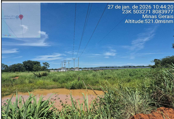
FT.20 - LOCAL 01 - PONTO DE ESTRUTURA ENERGÉTICA DA CONCESSIONÁRIA.
