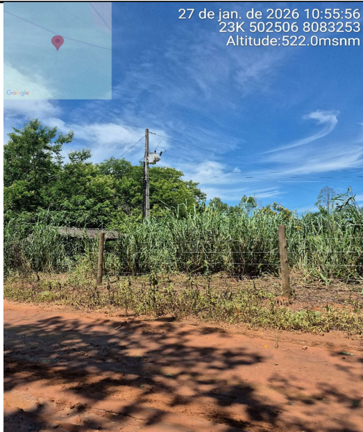
FT.23 - LOCAL 03 - PONTO DE ESTRUTURA ENERGÉTICA DA CONCESSIONÁRIA.
