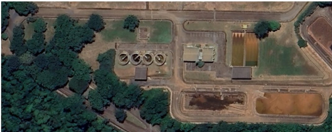
Figura 5: Vista Geral da UTR - Fonte: Arcadis.
