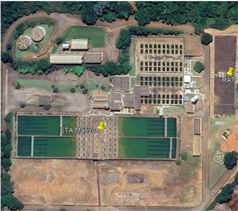
Figura 3 Vista ETA - Fonte: Arcadis.
