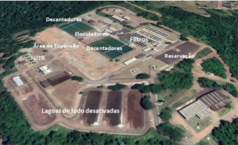
Figura 2: Vista ETA/UTR - Fonte: Arcadis.
