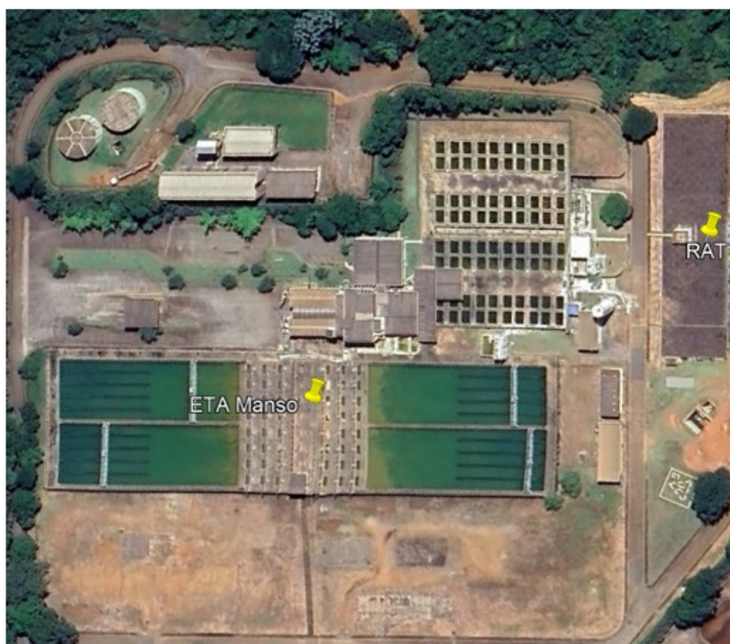
Figura 3 - Vista da área de ampliação da ETA.
