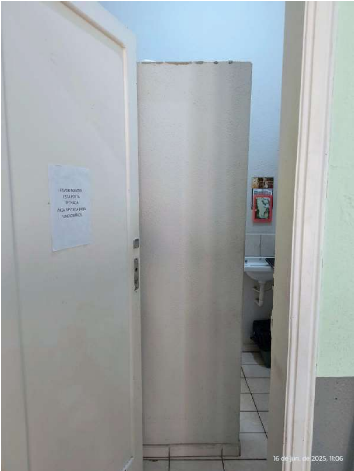
Figura 18 - Foto atual banheiro
