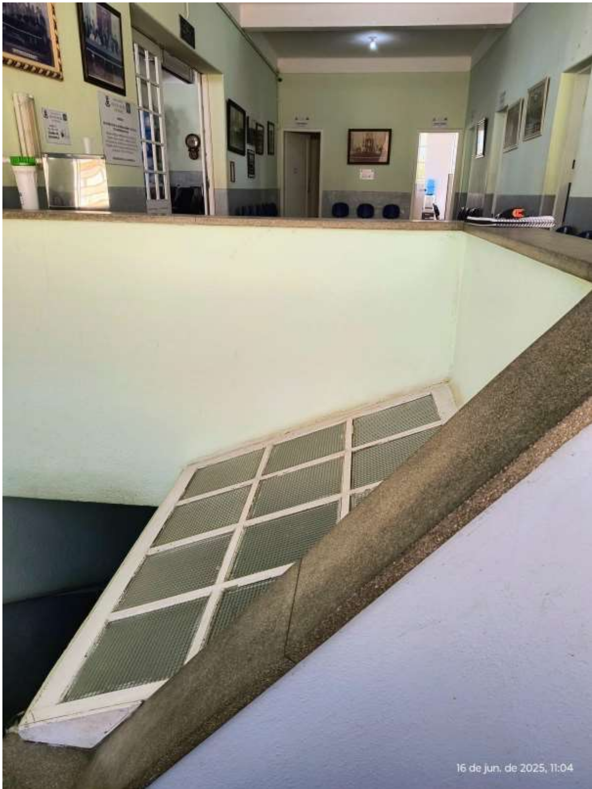
Figura 15- Foto 1 do vão para a instalação da plataforma elevatória
