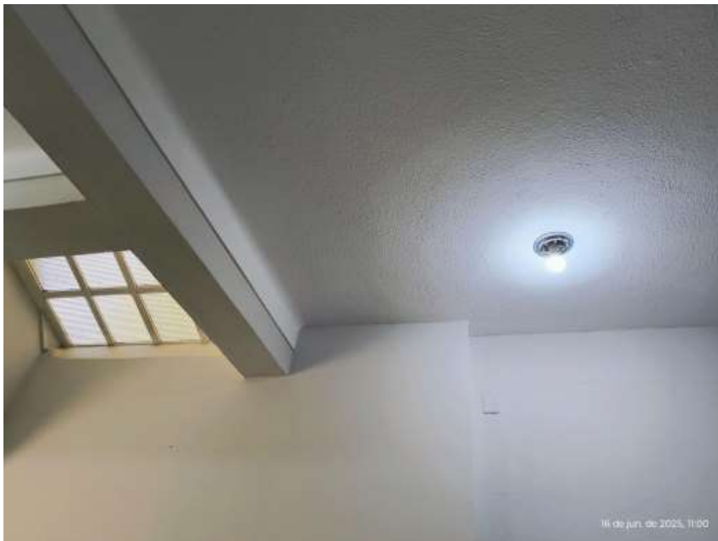
Figura 13 - Foto 1 do vão para a instalação da plataforma elevatória
