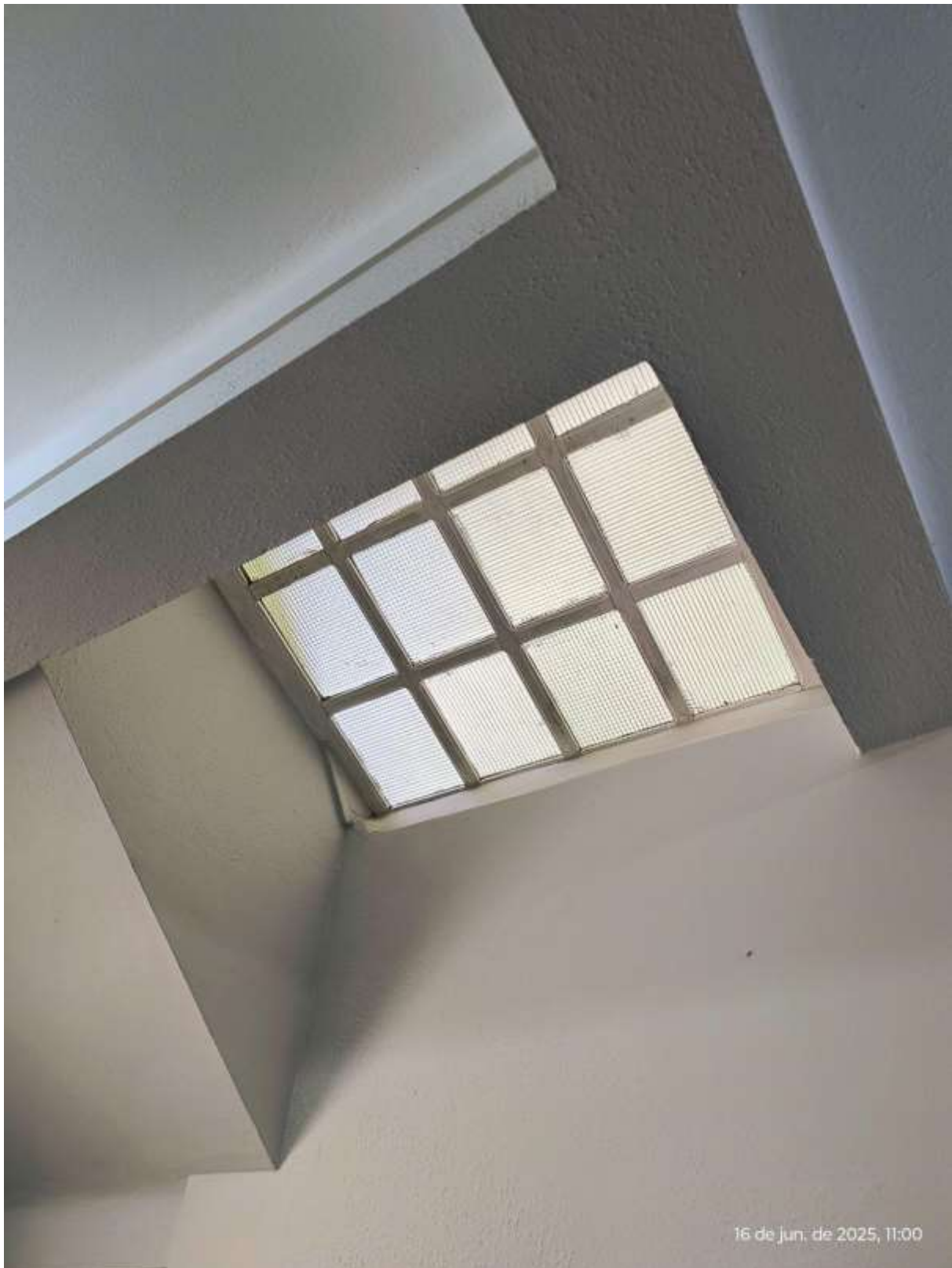
Figura 14 - Foto 2 do vão para a instalação da plataforma elevatória
