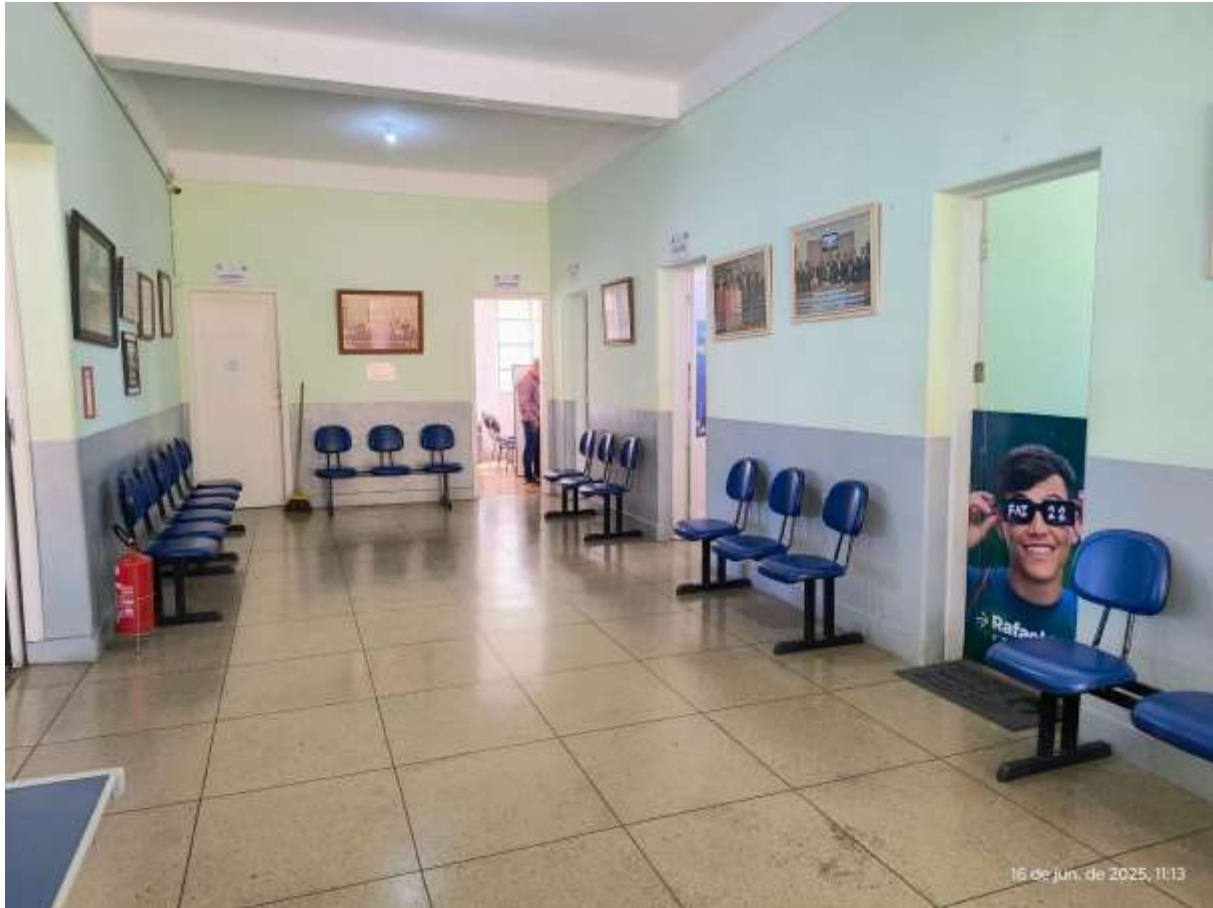
Figura 16 - foto do hall da porta do banheiro PNE
