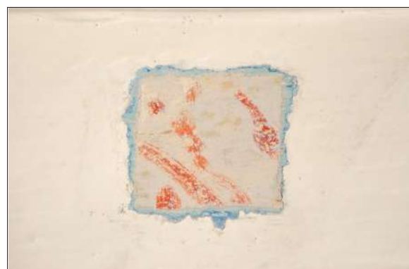
Foto: 0419 Detalhe do procedimento de prospecção, com abertura de pequena janela, para análise da camada pictórica.
