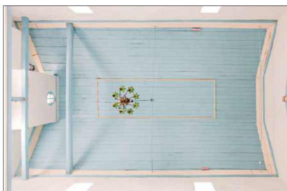
Foto: 0461 Forro da nave Plano geral
