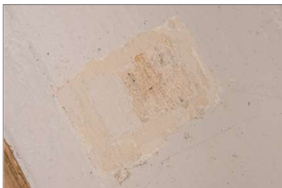
Foto: 0374 Detalhe do procedimento de prospecção, com abertura de pequena janela, para análise da camada pictórica.
