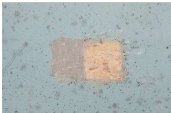
Foto: 0373 Detalhe do procedimento de prospecção, com abertura de pequena janela, para análise da camada pictórica.
