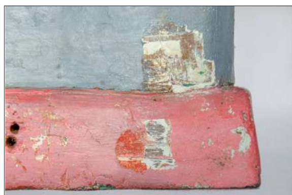
Foto: 0072 Detalhe do procedimento de prospecção, com abertura de pequena janela, para análise da camada pictórica.
