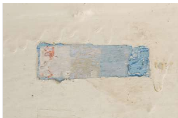
Foto: 0420 Detalhe do procedimento de prospecção, com abertura de pequena janela, para análise da camada pictórica.
