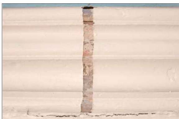
Foto: 0475 Detalhe do procedimento de prospecção, com abertura de pequena janela, para análise da camada pictórica.
