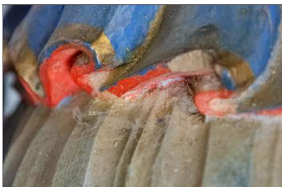
Foto: 0035 Detalhe do estado de conservação atual, com as degradações e patologias verificadas em análise.
