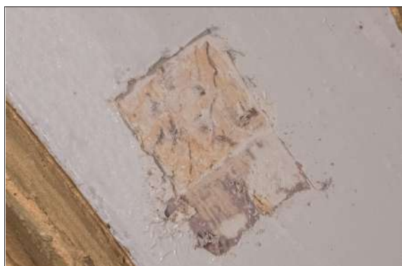
Foto: 0375 Detalhe do procedimento de prospecção, com abertura de pequena janela, para análise da camada pictórica.
