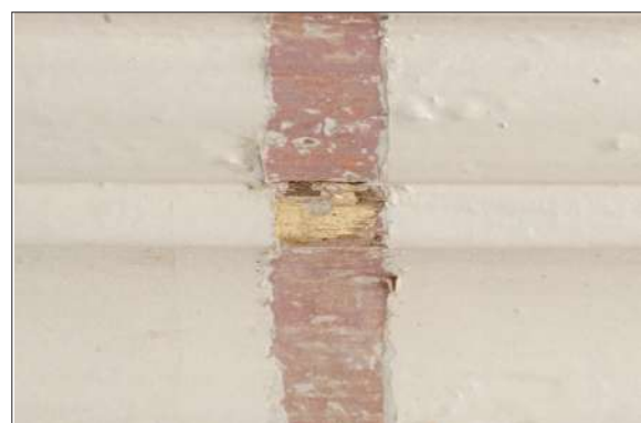
Foto: 0421 Detalhe do procedimento de prospecção, com abertura de pequena janela, para análise da camada pictórica.
