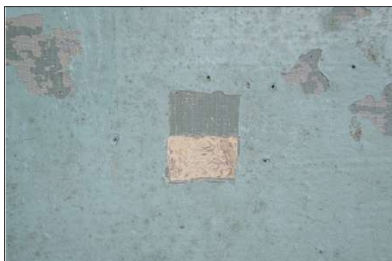
Foto: 0376 Detalhe do procedimento de prospecção, com abertura de pequena janela, para análise da camada pictórica.
