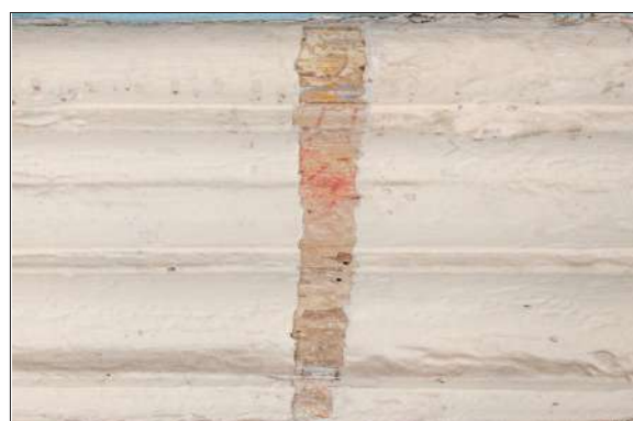
Foto: 0476 Detalhe do procedimento de prospecção, com abertura de pequena janela, para análise da camada pictórica.
