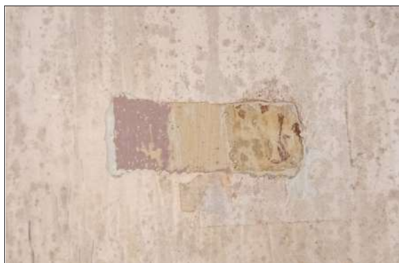
Foto: 0371 Detalhe do procedimento de prospecção, com abertura de pequena janela, para análise da camada pictórica.
