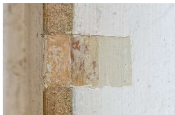
Foto: 0369 Detalhe do procedimento de prospecção, com abertura de pequena janela, para análise da camada pictórica.
