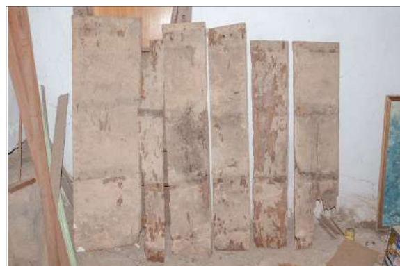
Foto: 0398 Retábulo-mor Plano detalhe - Forro do camarim
