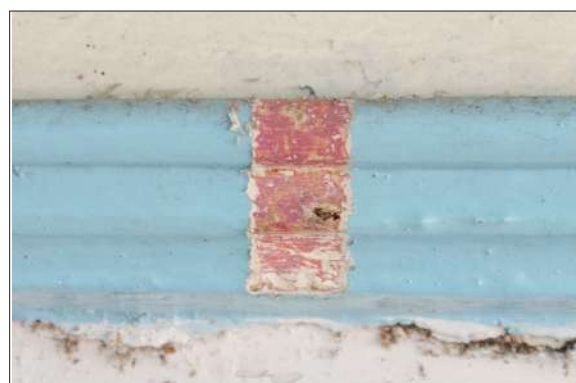
Foto: 0422 Detalhe do procedimento de prospecção, com abertura de pequena janela, para análise da camada pictórica.
