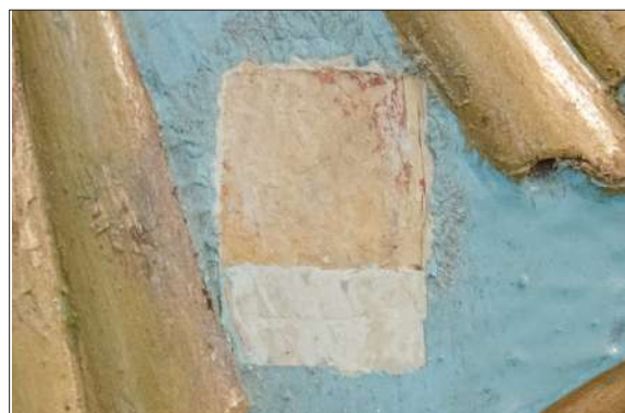
Foto: 0368 Detalhe do procedimento de prospecção, com abertura de pequena janela, para análise da camada pictórica.
