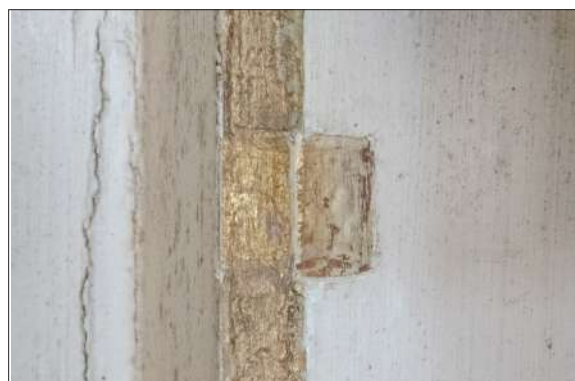
Foto: 0370 Detalhe do procedimento de prospecção, com abertura de pequena janela, para análise da camada pictórica.
