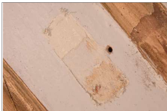
Foto: 0372 Detalhe do procedimento de prospecção, com abertura de pequena janela, para análise da camada pictórica.
