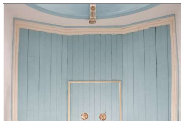
Foto: 0410 Forro da capela-mor Plano médio
