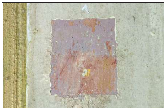
Foto: 0365 Detalhe do procedimento de prospecção, com abertura de pequena janela, para análise da camada pictórica.
