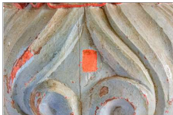
Foto: 0046 Detalhe do procedimento de prospecção, com abertura de pequena janela, para análise da camada pictórica.
