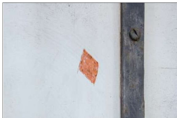
Foto: 0564 Detalhe do procedimento de prospecção, com abertura de pequena janela, para análise da camada pictórica.
