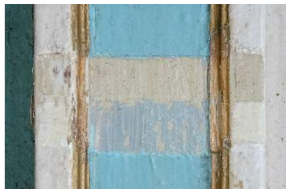
Foto: 0366 Detalhe do procedimento de prospecção, com abertura de pequena janela, para análise da camada pictórica.
