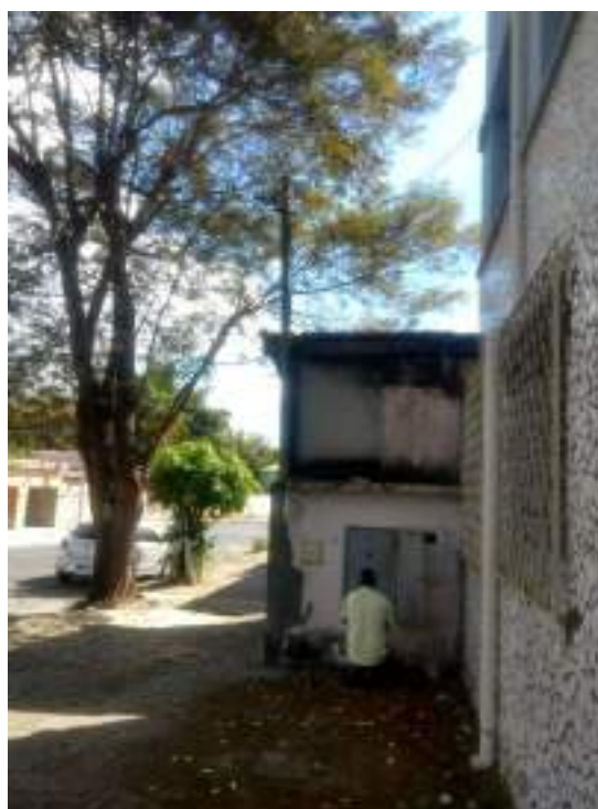
Figura 7 – Entrada de energia
