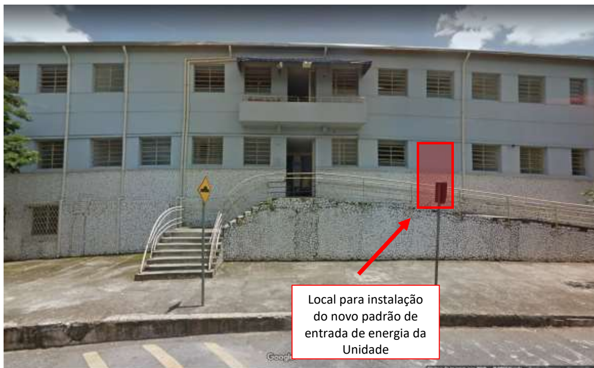
Fig. 03– Local para instalação do novo padrão de entrada de energia – Fachada do prédio da UAGC – Acervo FHEMIG
