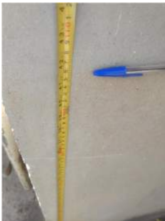
Figura 6 – Marca da enchente a 105 cm do piso.
