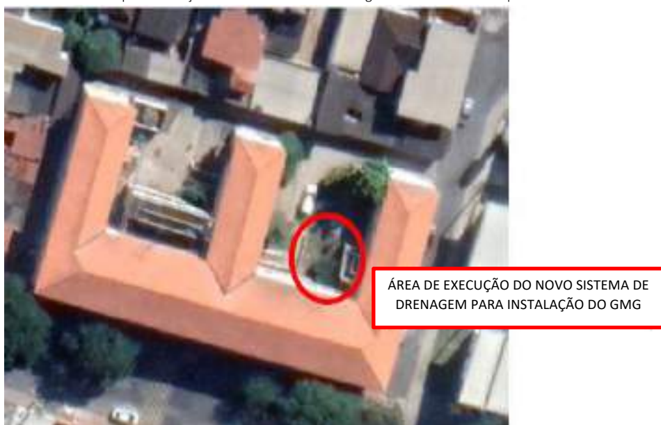
Figura 16 - Vista aérea do local para execução de novo sistema de drenagem da Unidade – CSSI | UAGC
