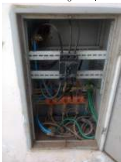
Figura 3 – Disjuntor Geral
