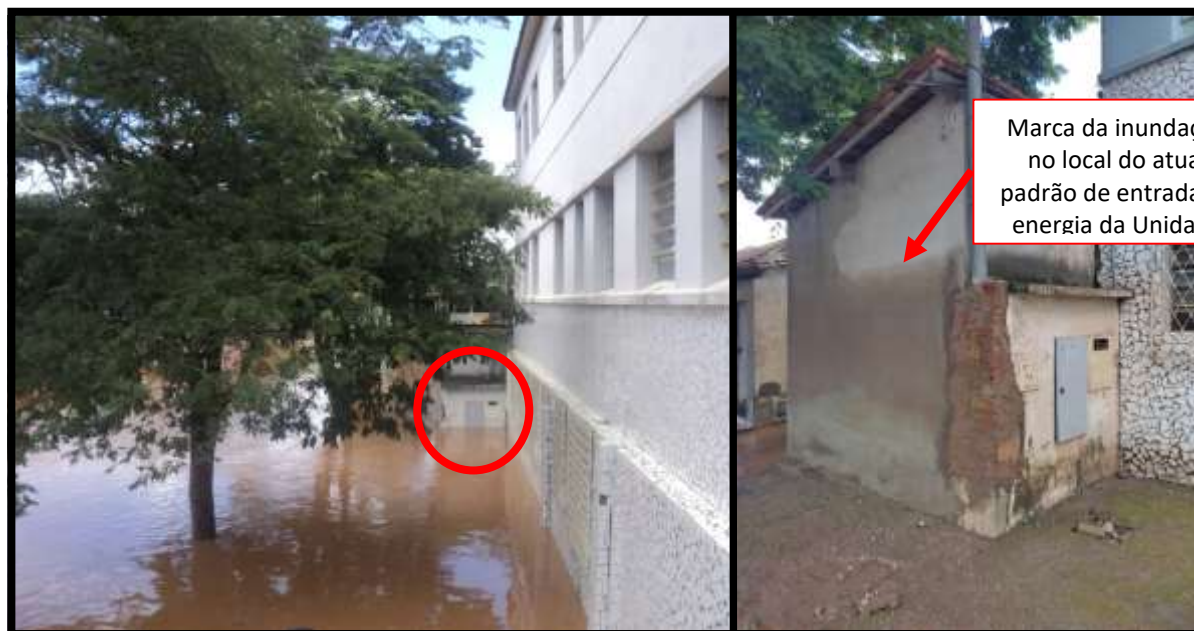
Fig. 02 – Atual local do padrão de entrada de energia – UAGC – Casa de Saúde Santa Izabel – Acervo FHEMIG
