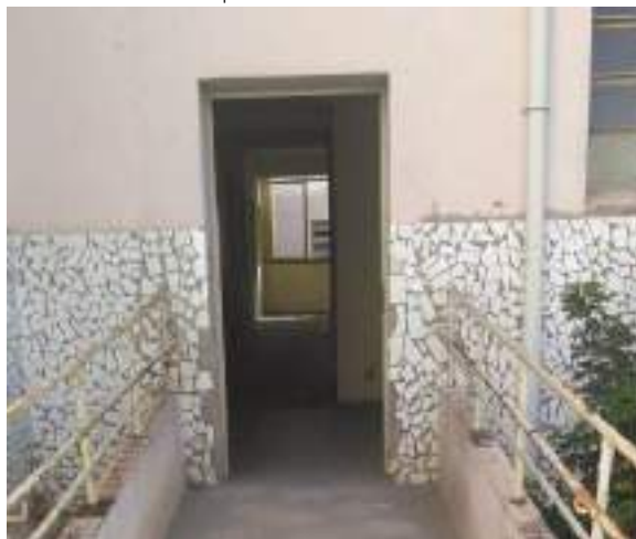
Foto 14 - Porta da Rampa de Acesso
