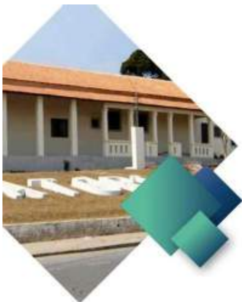
Foto 01 – Fachada Frontal - UAGC
