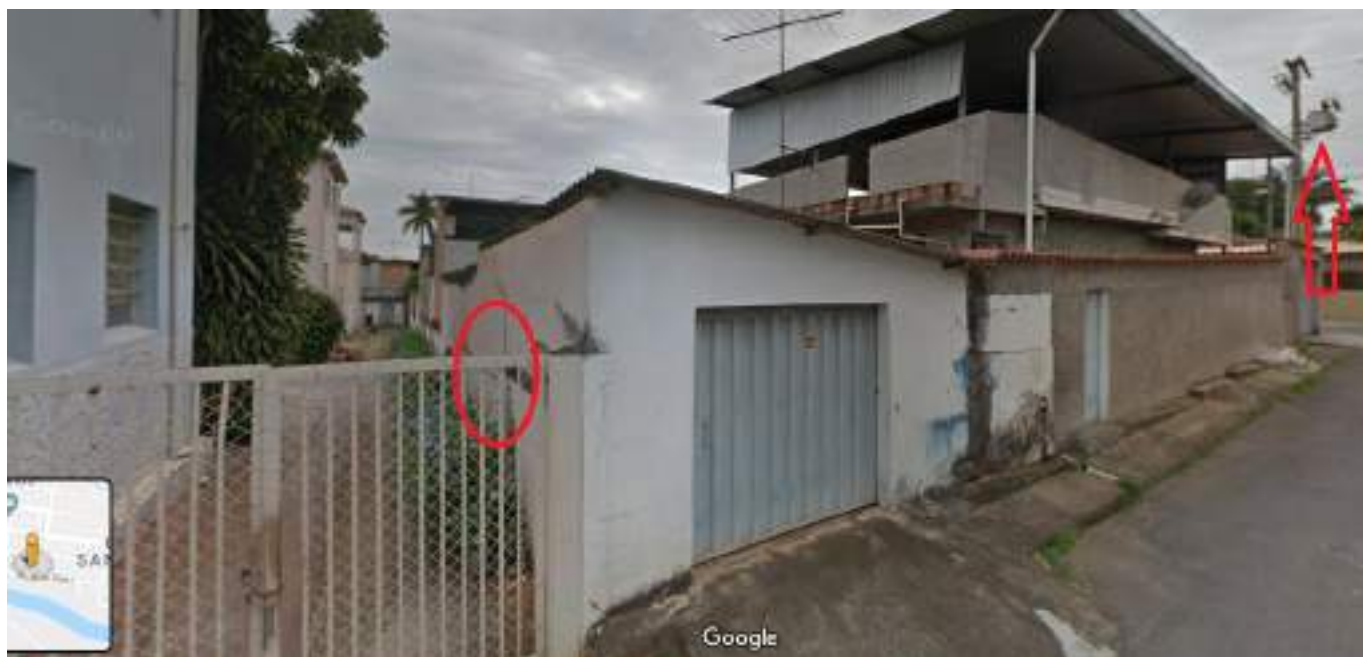
Figura 8 – Local de sugestão do novo padrão de energia e Indicação do Transformador.
