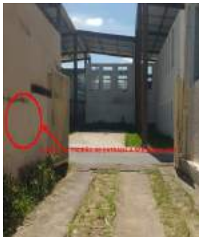
Foto 03: Local do novo padrão de entrada, a ser instalado.
