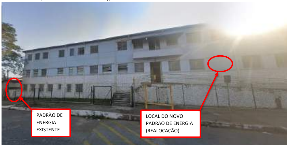
Foto 02 – Realocação Padrão de Entrada de Energia
