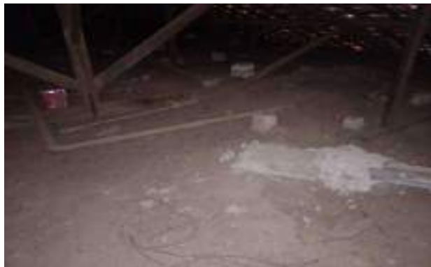
Foto 18 – Laje a ser impermeabilizada
