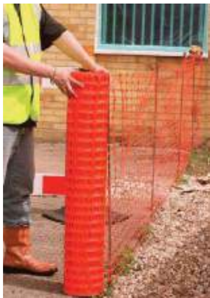
Figura 18 e 19 – Tela para proteção de transeunte (tipo cerquite)
