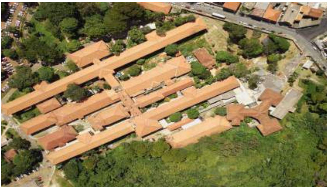
Foto 02 – Vista da cobertura
