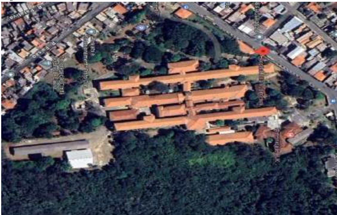
Imagem 04 – Vista da cobertura
