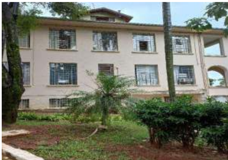
Foto 13 – Prédio da Diretoria
