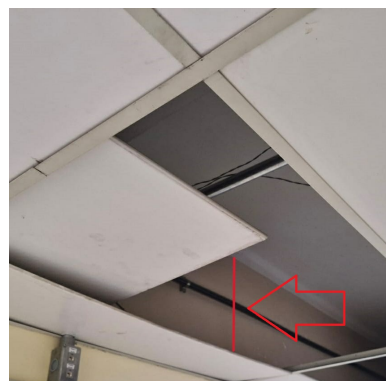
IMAGEM DISTÂNCIA ENTRE FORRO PVC E LAGE - APROX. 1 METRO
