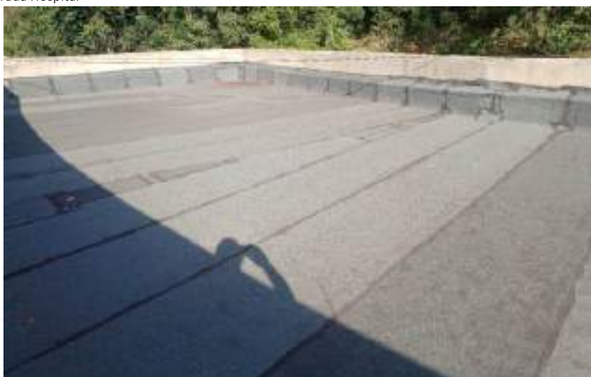
Foto 21 - Edifício Entrada Hospital
