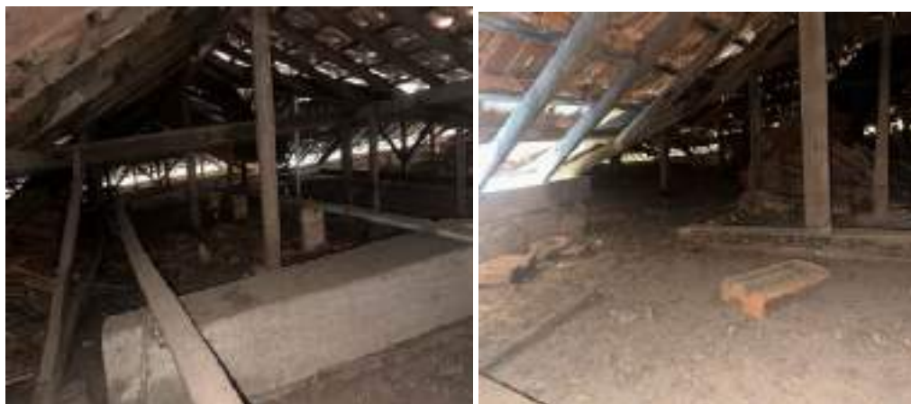
Fotos 22 e 23 — Detalhe Telhamento
