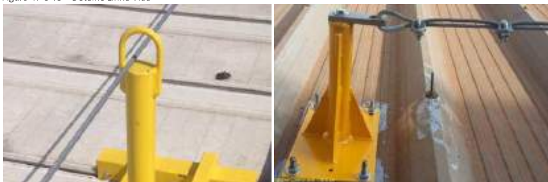
Figura 47 e 48 – Detalhe Linha Vida
