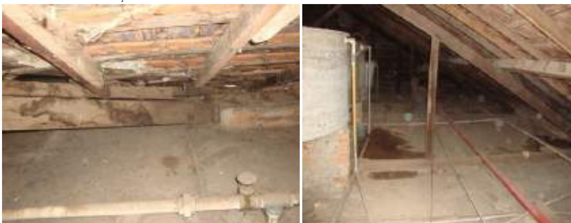
Fotos 43 e 44 – Detalhes Tubulações sob telhamento
