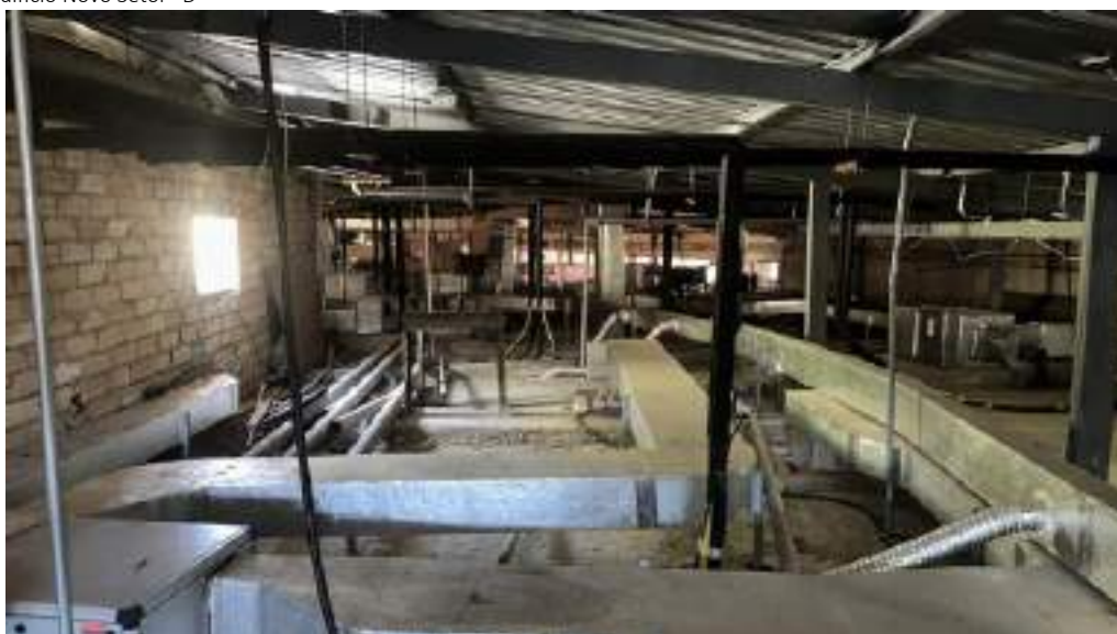
Foto 20 - Edifício Novo Setor "D"
