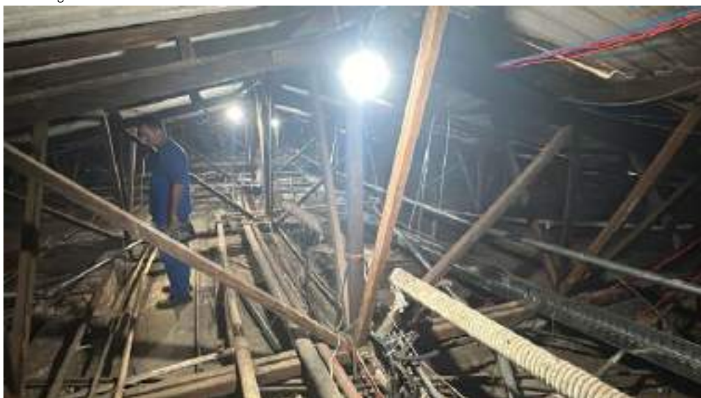
Foto 40 – Detalhe engradamento e Telhas
