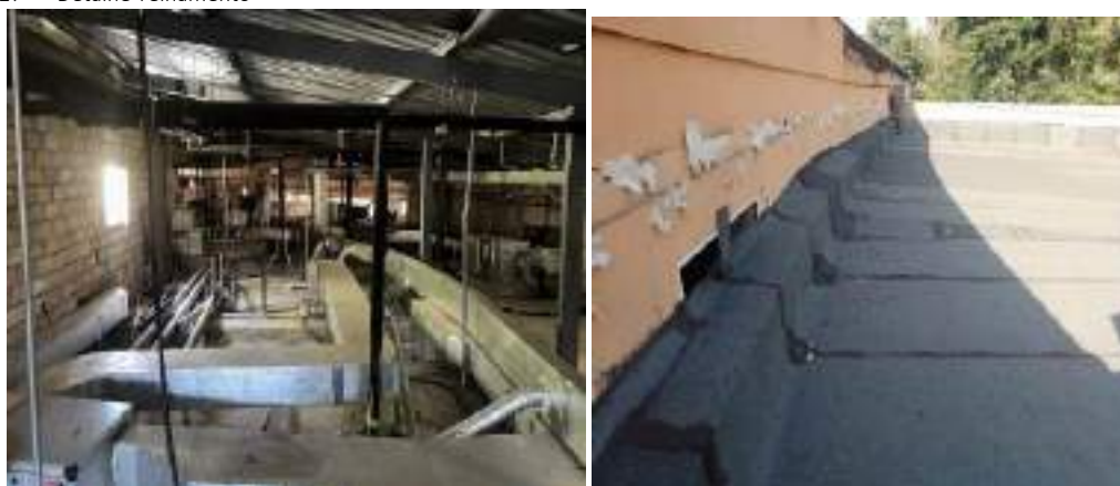
Fotos 26 e 27 — Detalhe Telhamento
