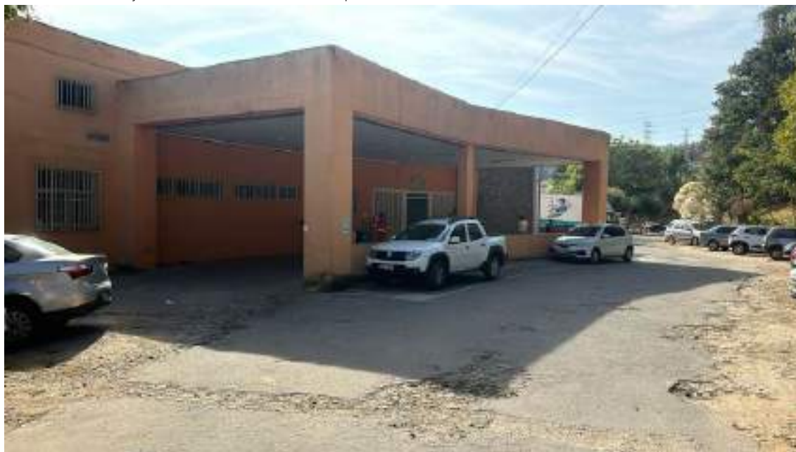
Foto 74 – Detalhes Lajes e Cobertura Prédio Entrada Hospital
