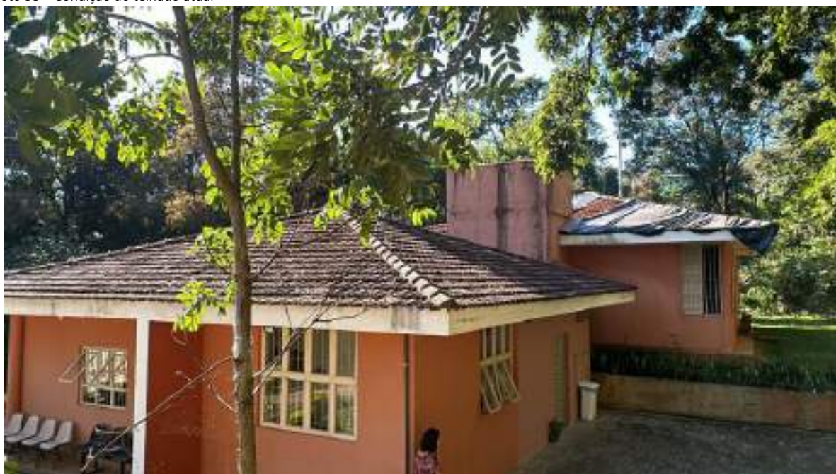
Foto 53 – Condição do telhado atual
