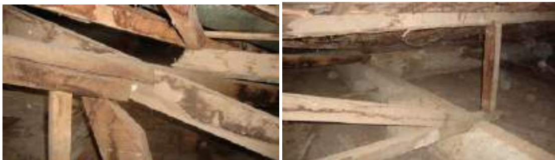
Fotos 37 e 38 – Detalhe Telhamento
