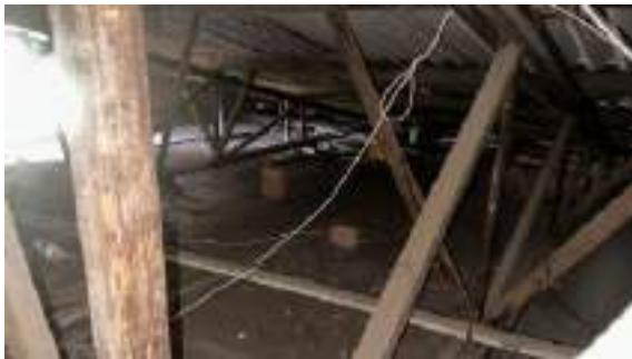
Fotos 02 e 03 – Detalhe sarrafos
