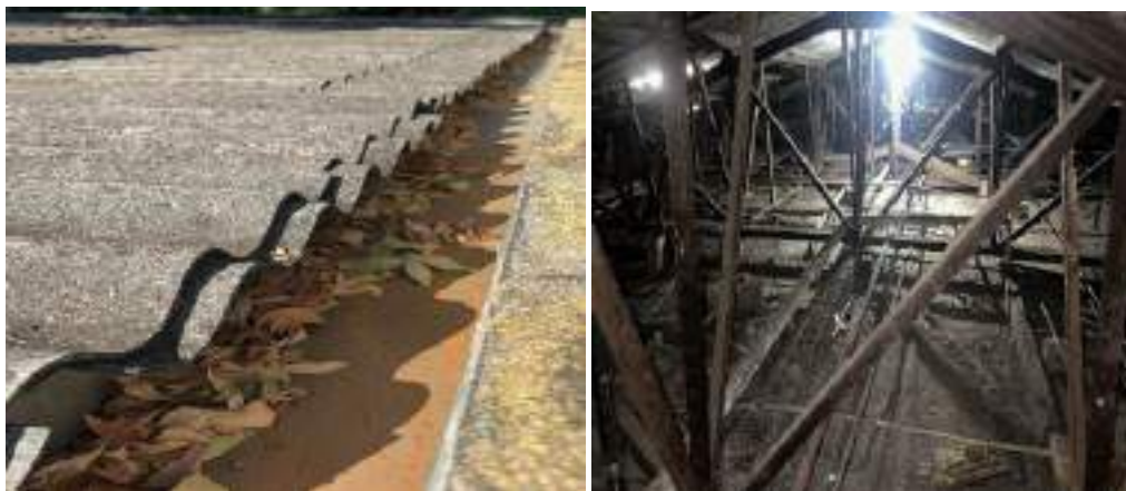
Fotos 24 e 25 — Detalhe Telhamento
