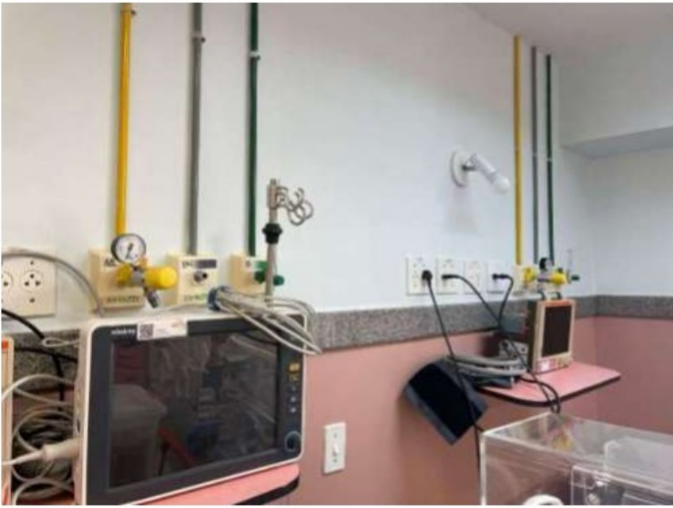
Foto 1 - Maternidade HRJP - Postos de utilização existentes, Acervo FHEMIG
