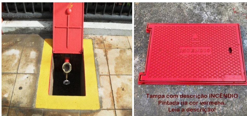
Figura 7 – Imagem Ilustrativa do Hidrante de Recalque devidamente instalado
