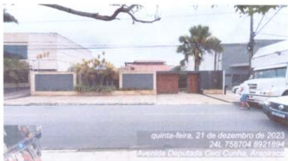
Fachada da Avenida Deputada Ceci Cunha
