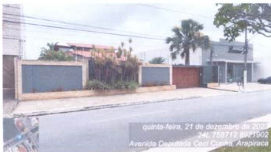
Fachada da Avenida Deputada Ceci Cunha
