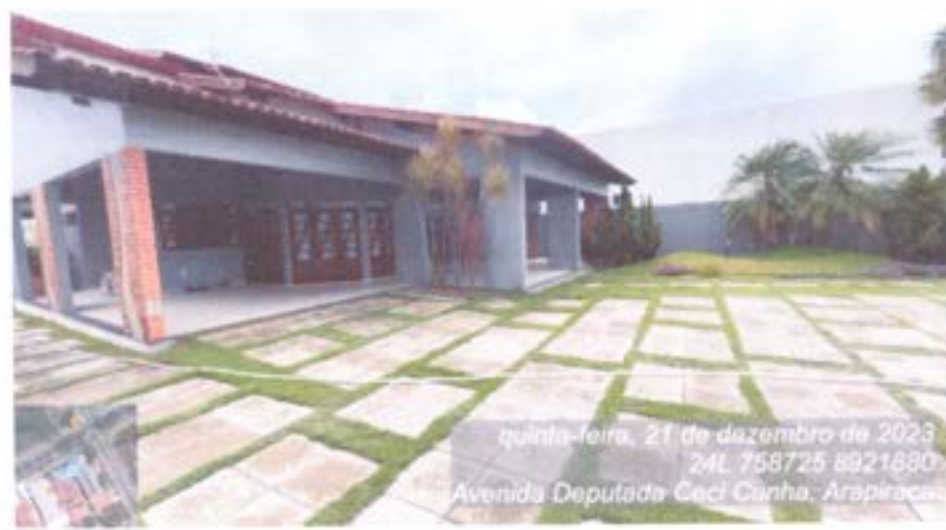
Fachada interna do Imóvel
