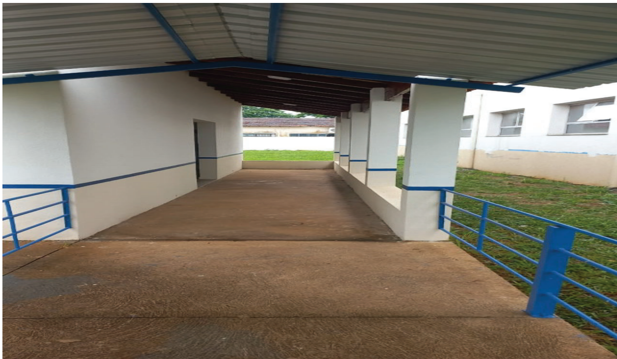
Parte externa dos banheiros.
