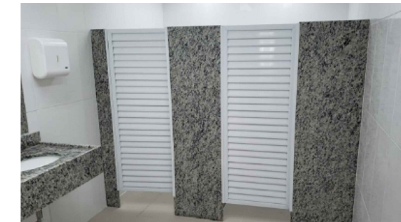
BANCADAS E DIVISÓRIAS DOS BANHEIROS EM GRANITO CINZA ANDORINHA
