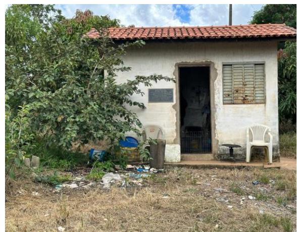
Figura 51 – Casa de apoio aos catadores que trabalham no local.
