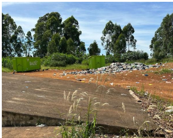
Figura 23 – RSU sobre solo natural na estação de transbordo em Arapuá
