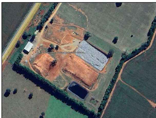
Figura 5: Trincheiras 01,02 e Lagoa de chorume já instaladas e em operação.
