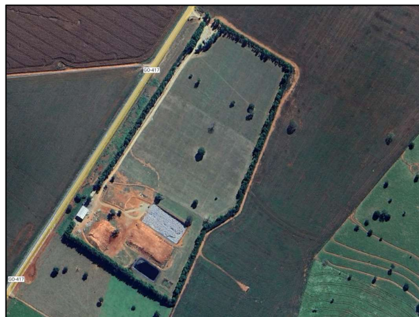
Figura 4: Nova lagoa impermeabilizada.
