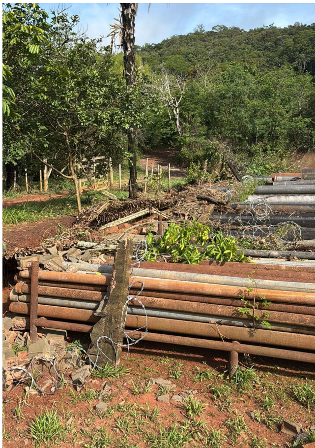
Fotografia 1 - MURO ETA GATOS COLAPSADO LATITUDE -19.585054°, LONGITUDE -43.195531°.
