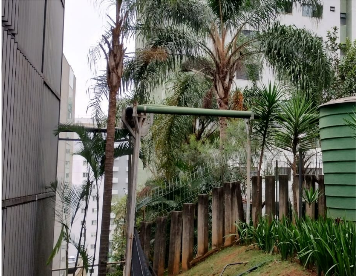
ESTRUTURA EXISTENTE ONDE SERÁ REALIZADO O SERVIÇO.
