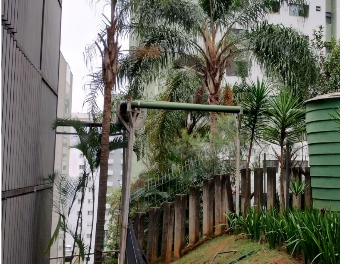
ESTRUTURA EXISTENTE ONDE SERÁ REALIZADO O SERVIÇO.
