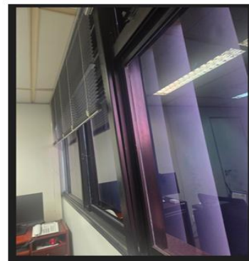
Foto 4 - Vista da janela acústica que deverá ser complementada
