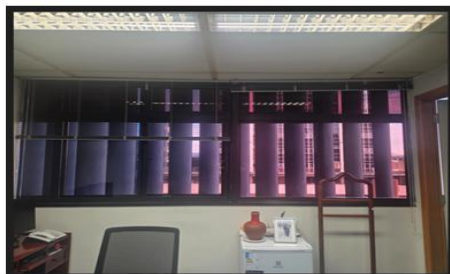
Foto 3 - Vista da janela acústica que deverá ser complementada
