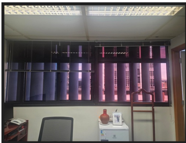
Foto 3 - Vista da janela acústica que deverá ser complementada
