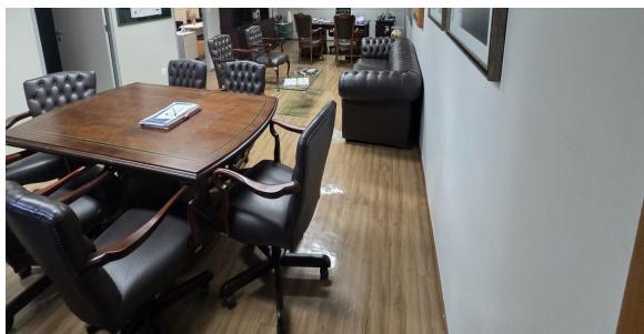
Foto 1 - Vista geral do Gabinete - Detalhes para paredes e forro
