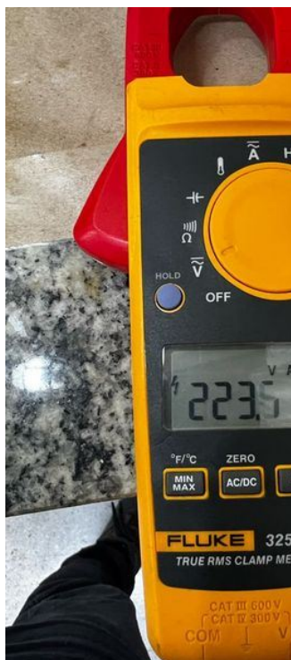
Tensão elétrica de alimentação.
