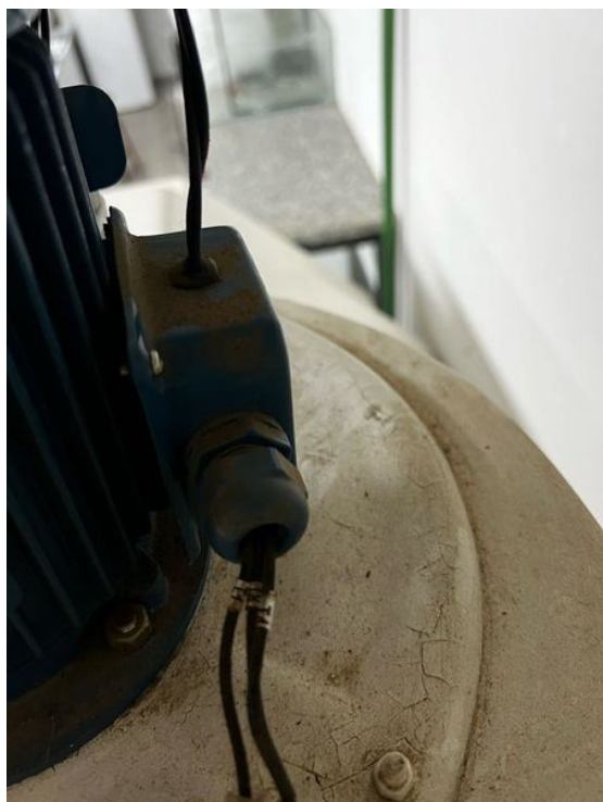
Correção na fixação da tampa do motor.
