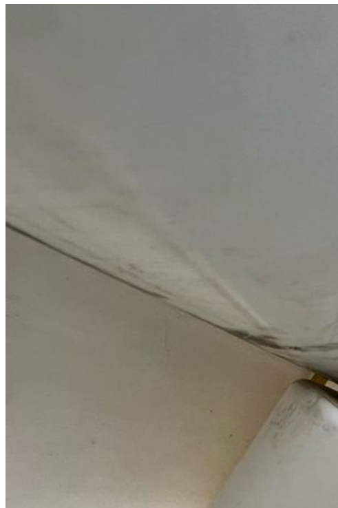
Detalhe do duto.
