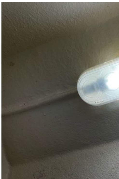
Correção do mau contato elétrico da lâmpada do lado esquerdo.
