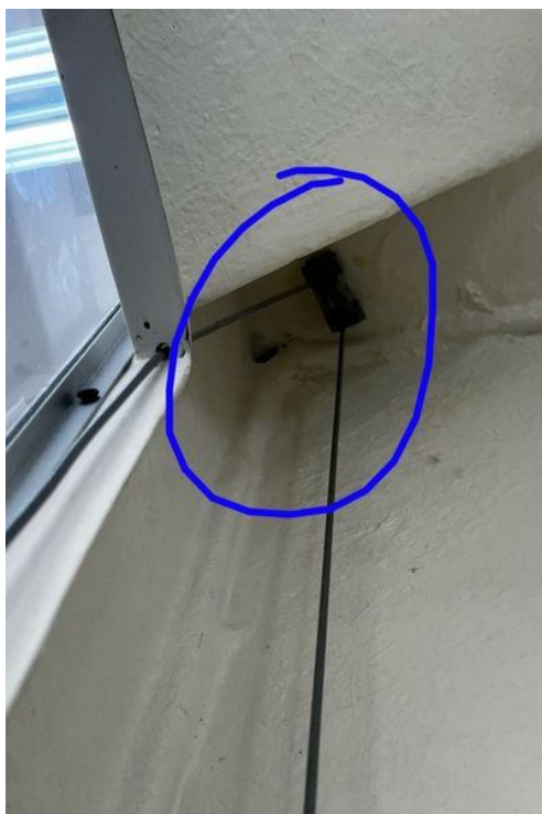
Realizado o destravamento do rolamento do sistema do contrapeso.
