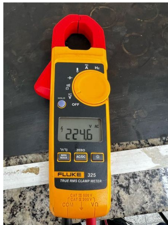
Tensão elétrica de alimentação.
