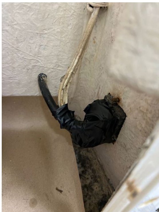
Isolamento da parte elétrica.
