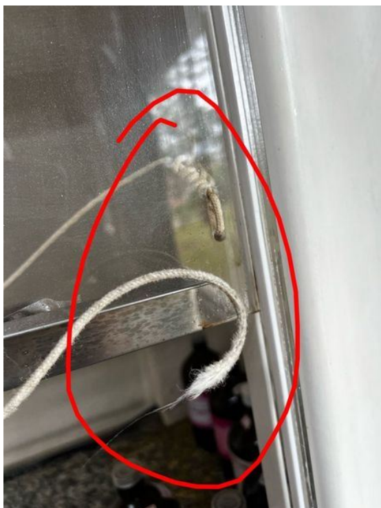
Corda do contra peso da tampa está quebrado.
