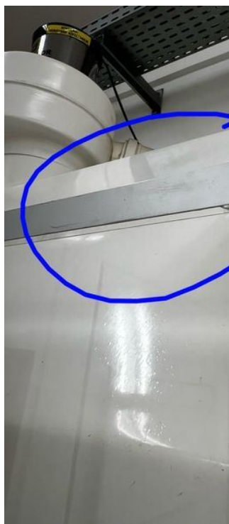
Feito a correção na fixação do batente da tampa de acrílico.
