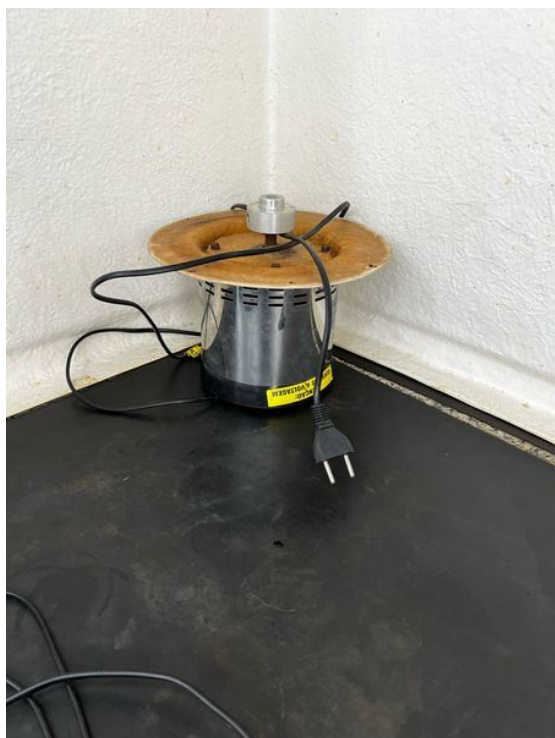
Motor deixado dentro da capela.
