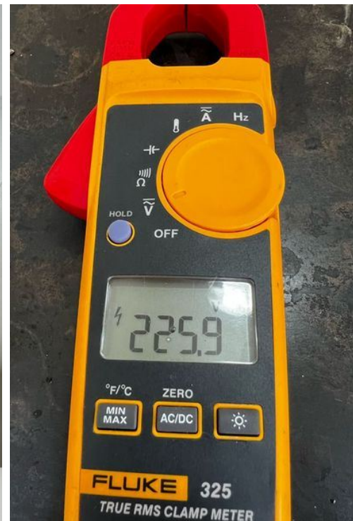
Tensão elétrica de alimentação.
