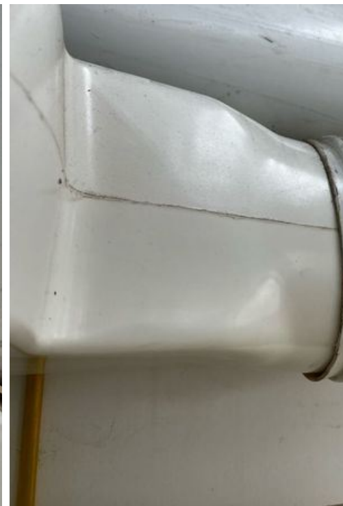
Detalhe do duto.
