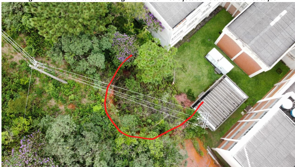
Figura 9 - Vista aérea do escorregamento nas imediações da Faculdade de Educação
