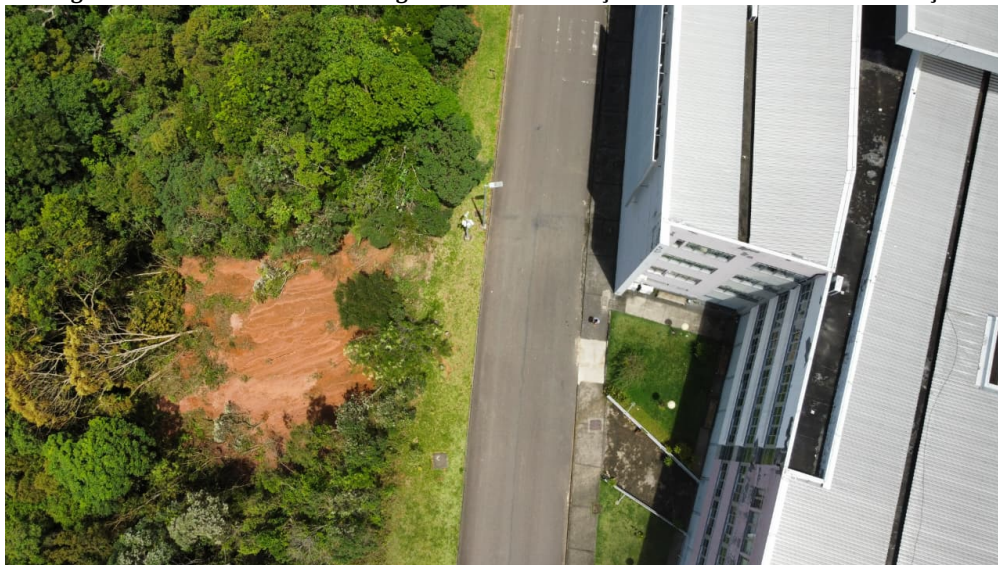
Figura 10 - Vista aérea do escorregamento nas imediações da Faculdade de Comunicação
