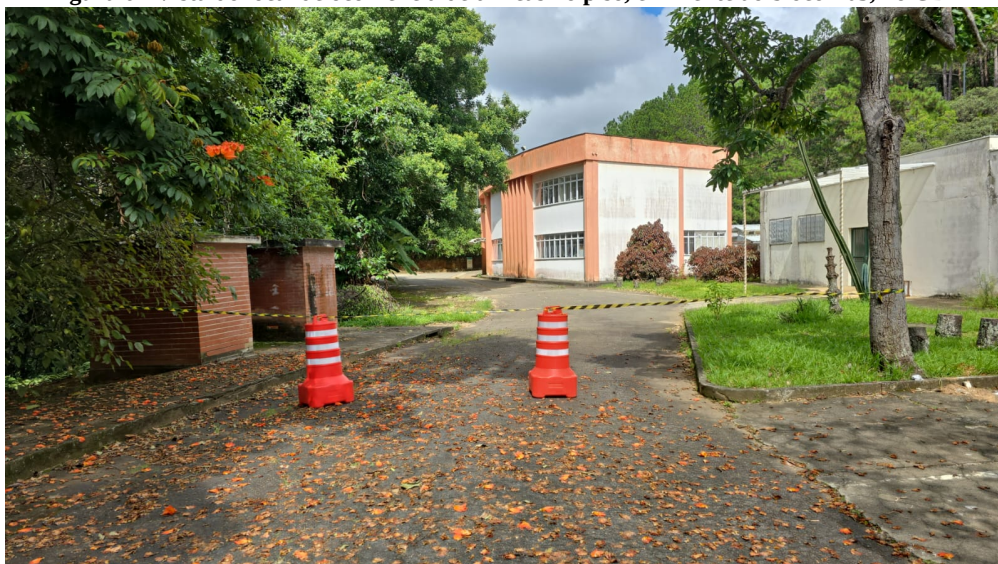
Figura 6 - Vista do local de ocorrência de trincas no piso, em frente ao bloco F03, no CBR
