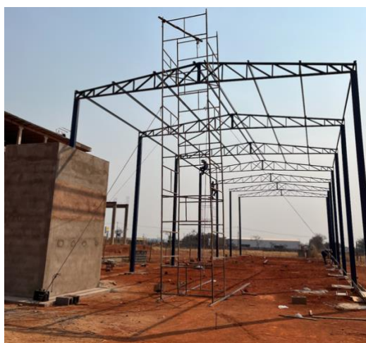
Montagem do galpão: b) agosto 2024
