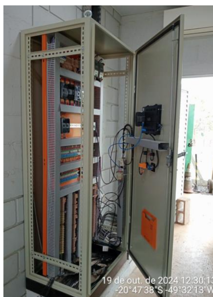
Figura 2 – Instrumentação do queimador: a) sensores montados no queimador e b) painel elétrico
