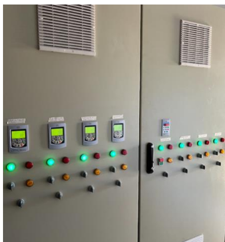
Figura 1 – Painéis de controle do reator, ventiladores e lavador de gases montados pela empresa ENGEPROJET – Sistemas e Automação LTDA na empresa CALMECON.
