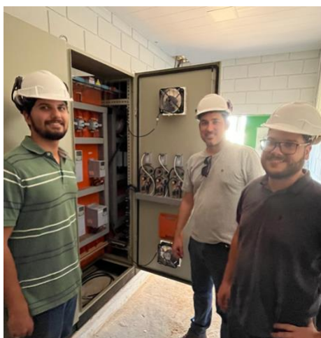
Figura 1 – Painéis de controle do reator, ventiladores e lavador de gases montados pela empresa ENGEPROJET – Sistemas e Automação LTDA na empresa CALMECON.
