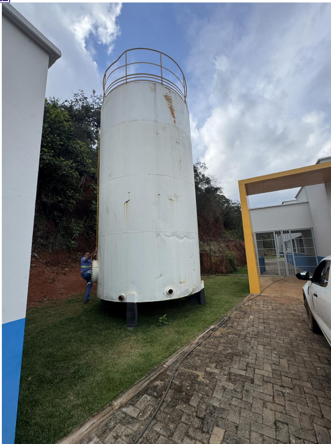
Figura 01 – Vista geral do reservatório metálico existente
