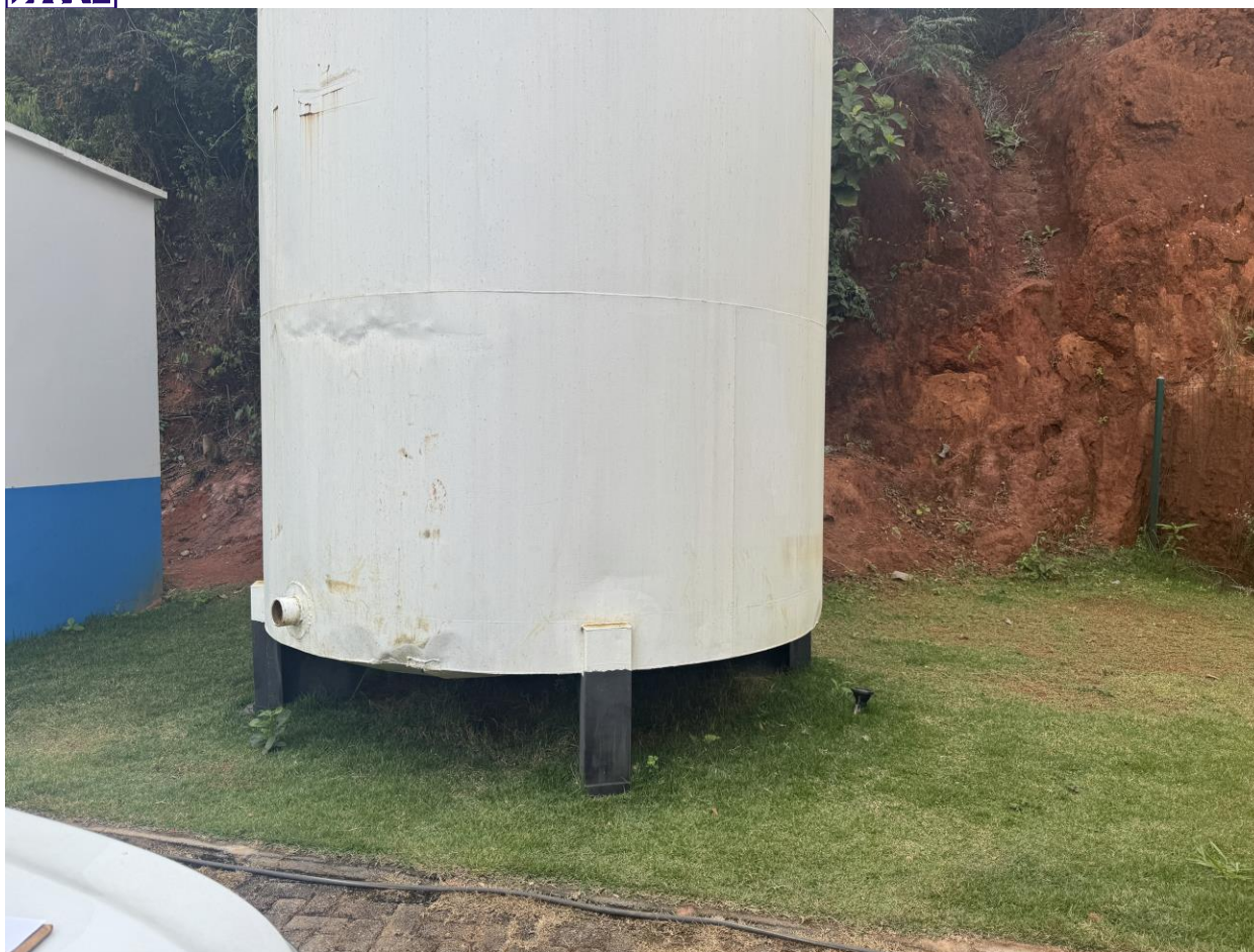
Figura 02 – Detalhe do reservatório metálico existente
