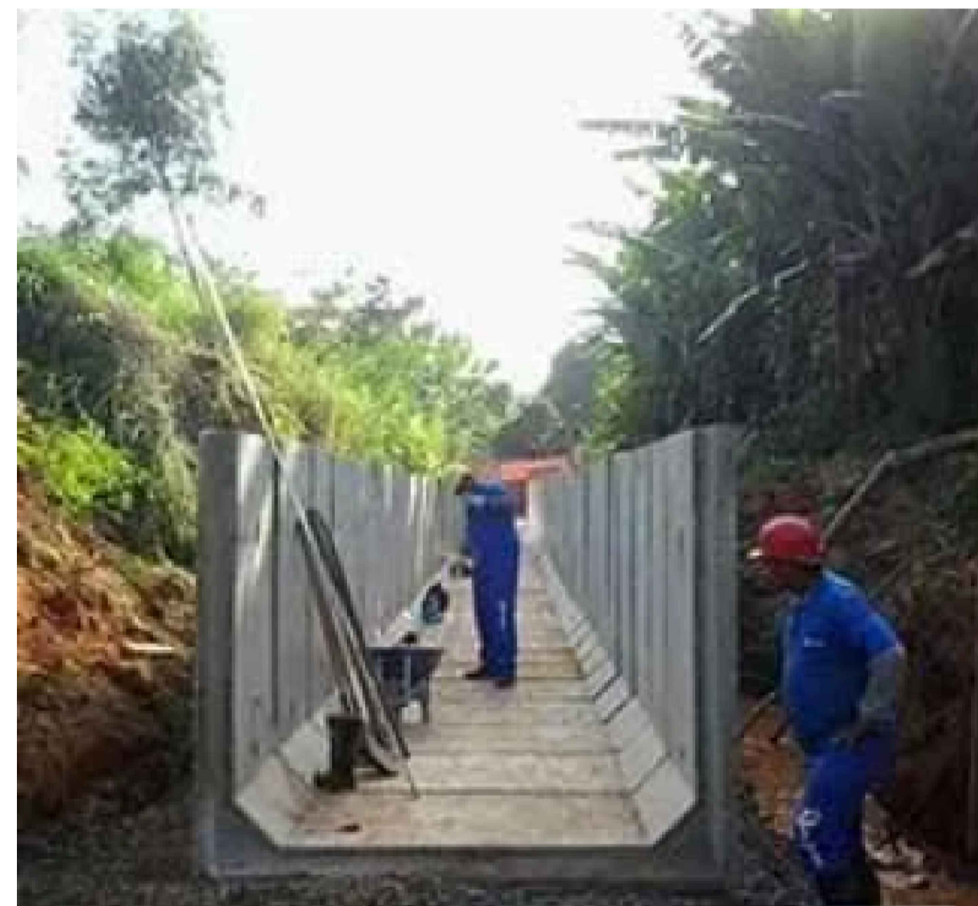
IMAGEM ILUSTRATIVA-GALERIA SEÇÃO ABERTA (FONTE: PORTAL AECweb)
