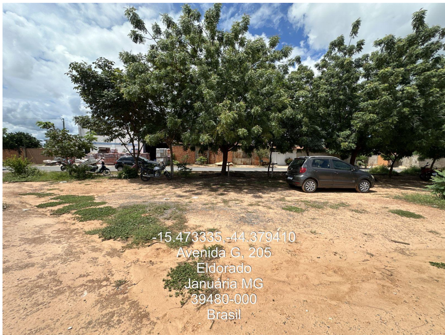
Figura 07. Local do futuro Prédio da UBS- 01/04/2026.
