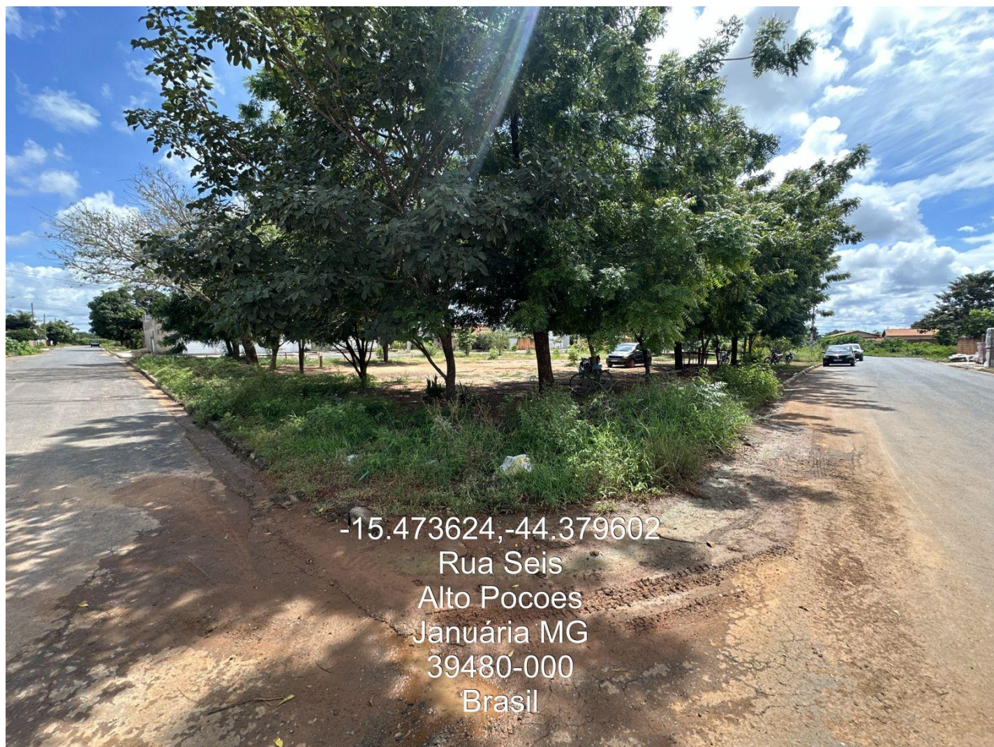
Figura 03. Local do futuro Prédio da UBS- 01/04/2026.
