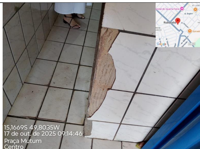
Figura 2 - Banheiro a receber intervenção
