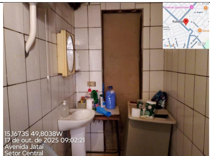
Figura 4 - Banheiro a receber intervenção e adequação
