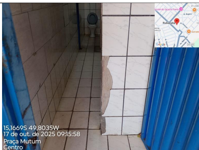
Figura 8- Banheiro a receber intervenção e reforma, com adequação para melhorias
