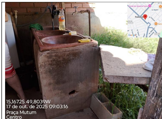
Figura 9- Local aberto onde será executado com cobertura com implantação da área de serviço
