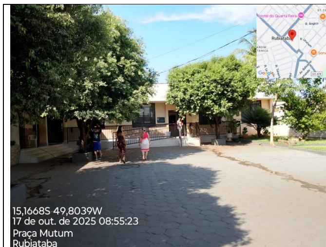
Figura 1 – Entrada e fachada interna da Escola onde será realizado o serviço.
