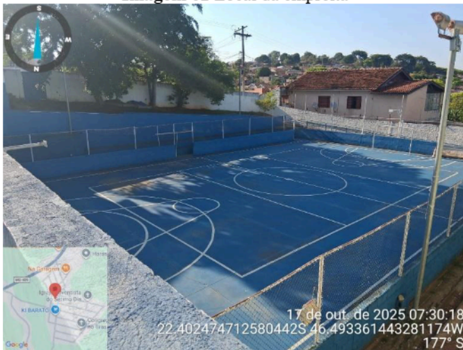
Fonte: Fiscalização de Obras.
