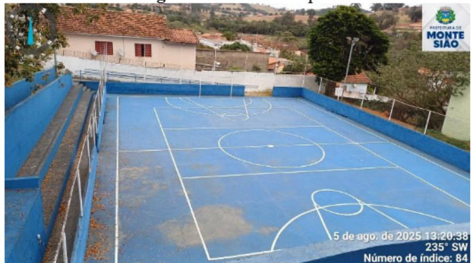
Fonte: Fiscalização de Obras.
