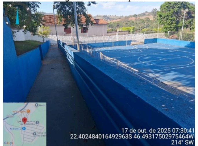
Fonte: Fiscalização de Obras.
