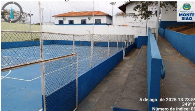
Fonte: Fiscalização de Obras.
