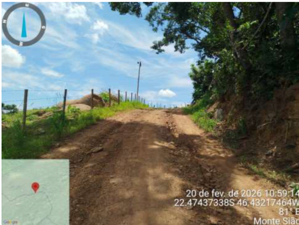
Foto n° 5 – ESTRADA MUNICIPAL – TRECHO 02
