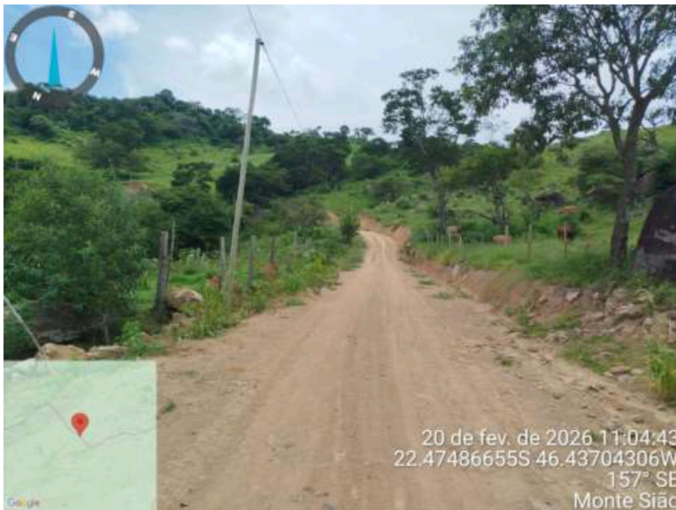
Foto nº 3 – ESTRADA MUNICIPAL – TRECHO 01
