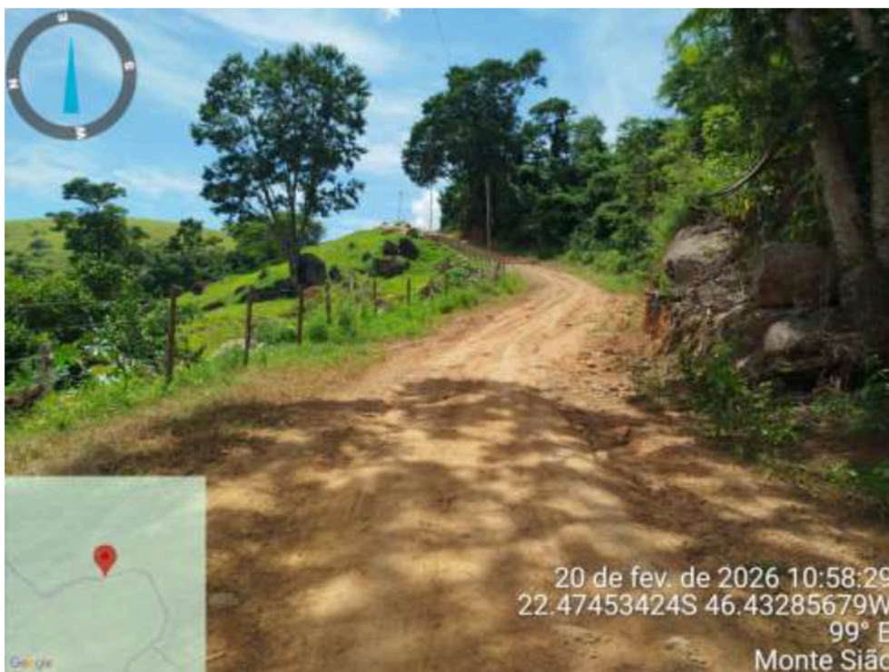
Foto n° 6 – ESTRADA MUNICIPAL – TRECHO 02
