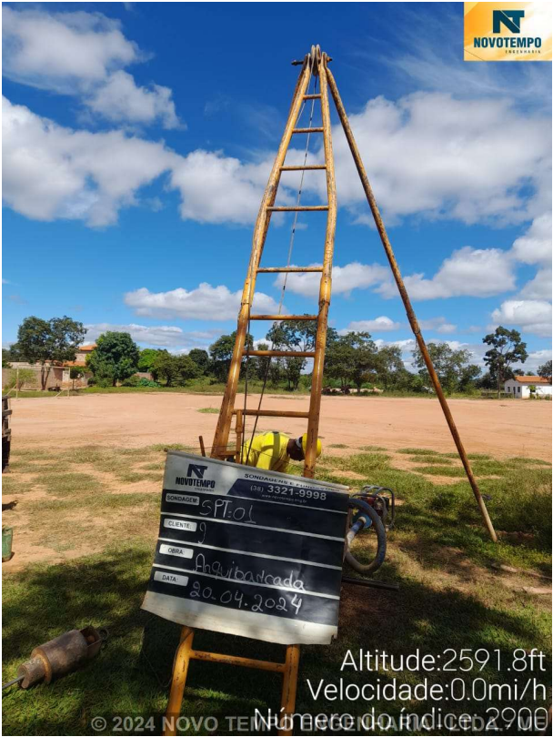
Foto 1 – EXECUÇÃO SONDAGEM À PERCUSSÃO SP 01 - DISTRI. DE ALVAÇÃO-CORAÇÃO DE JESUS/MG
