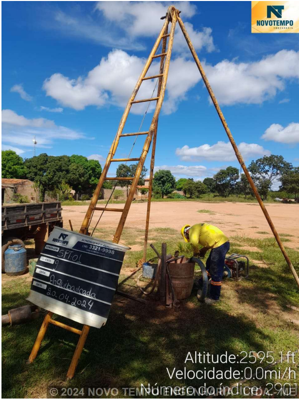
Foto 2 – EXECUÇÃO SONDAGEM À PERCUSSÃO SP 01 - DISTRI. DE ALVAÇÃO-CORAÇÃO DE JESUS/MG
