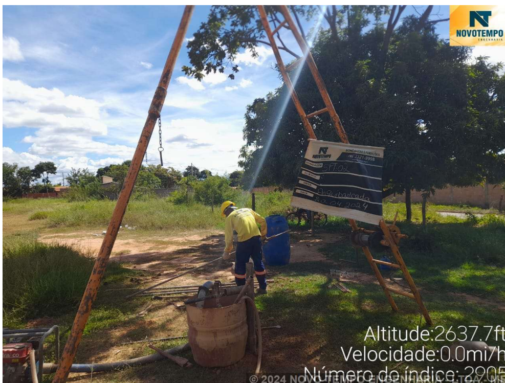
Foto 2 – EXECUÇÃO SONDAGEM À PERCUSSÃO SP 02 - DISTRI. DE ALVAÇÃO-CORAÇÃO DE JESUS/MG
