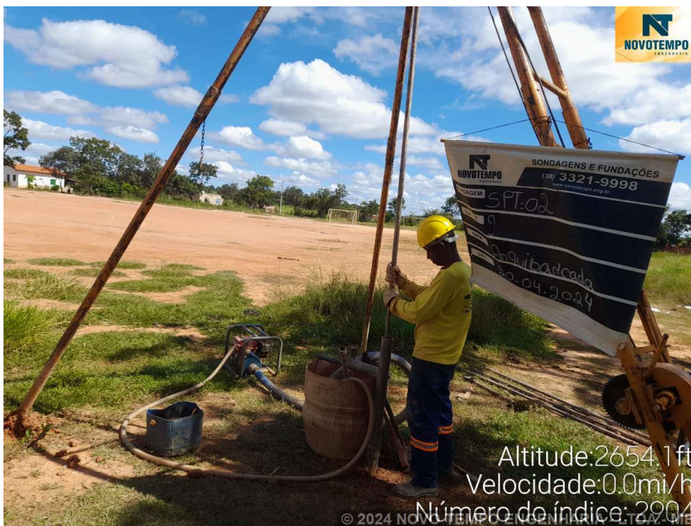
Foto 1 – EXECUÇÃO SONDAGEM À PERCUSSÃO SP 02 - DISTRI. DE ALVAÇÃO-CORAÇÃO DE JESUS/MG
