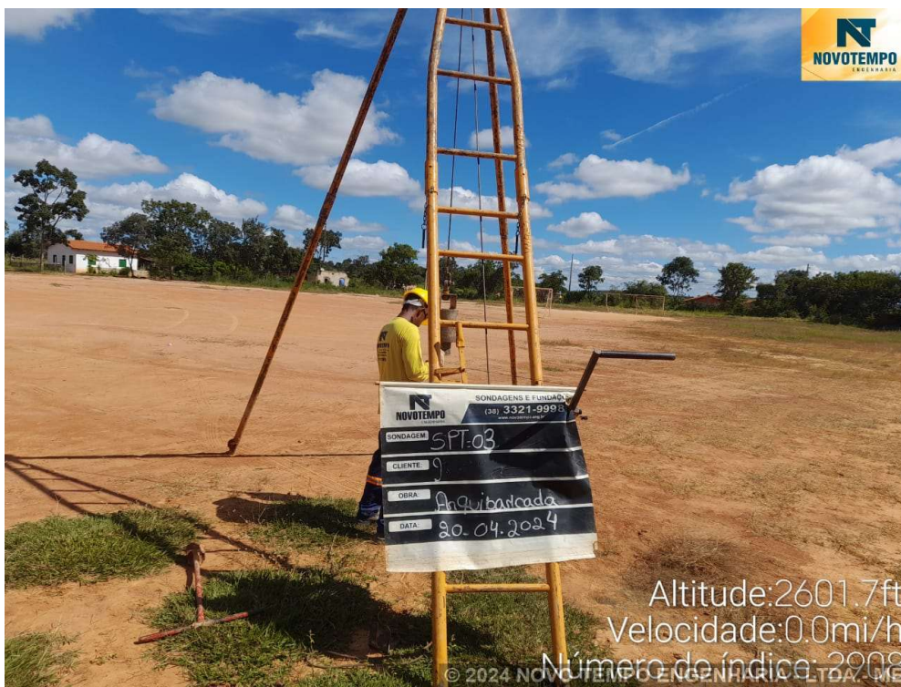
Foto 1 – EXECUÇÃO SONDAGEM À PERCUSSÃO SP 03 - DISTRI. DE ALVAÇÃO-CORAÇÃO DE JESUS/MG
