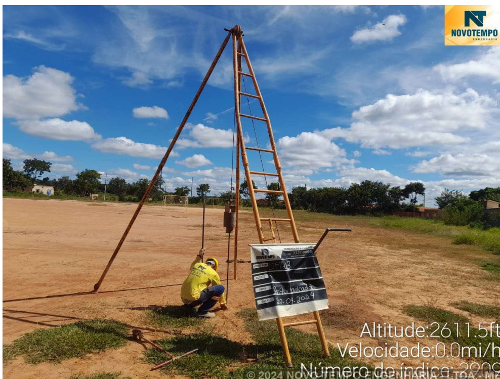
Foto 2 – EXECUÇÃO SONDAGEM À PERCUSSÃO SP 03 - DISTRI. DE ALVAÇÃO-CORAÇÃO DE JESUS/MG
