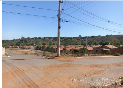
Quadra 04: vista do cruzamento das ruas "E" e Coordenadas: Lat. -16°42'21"; Long. -44°20'43"
