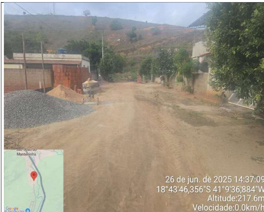
FOTO 05: RUA YPÊ ROSA TRECHO 01
