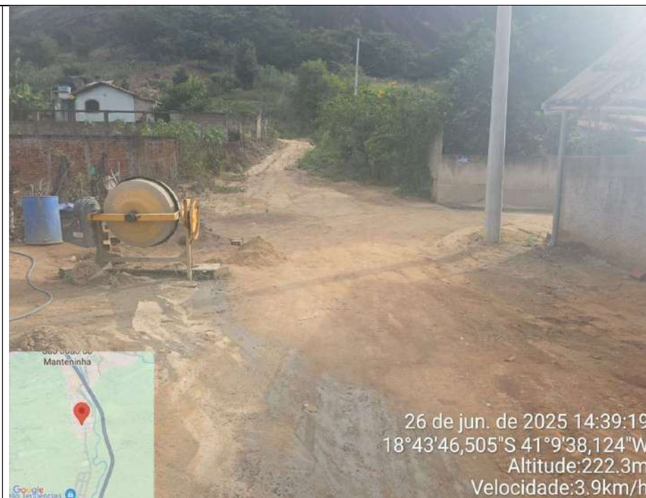
FOTO 08: RUA YPÊ ROSA TRECHO 02
